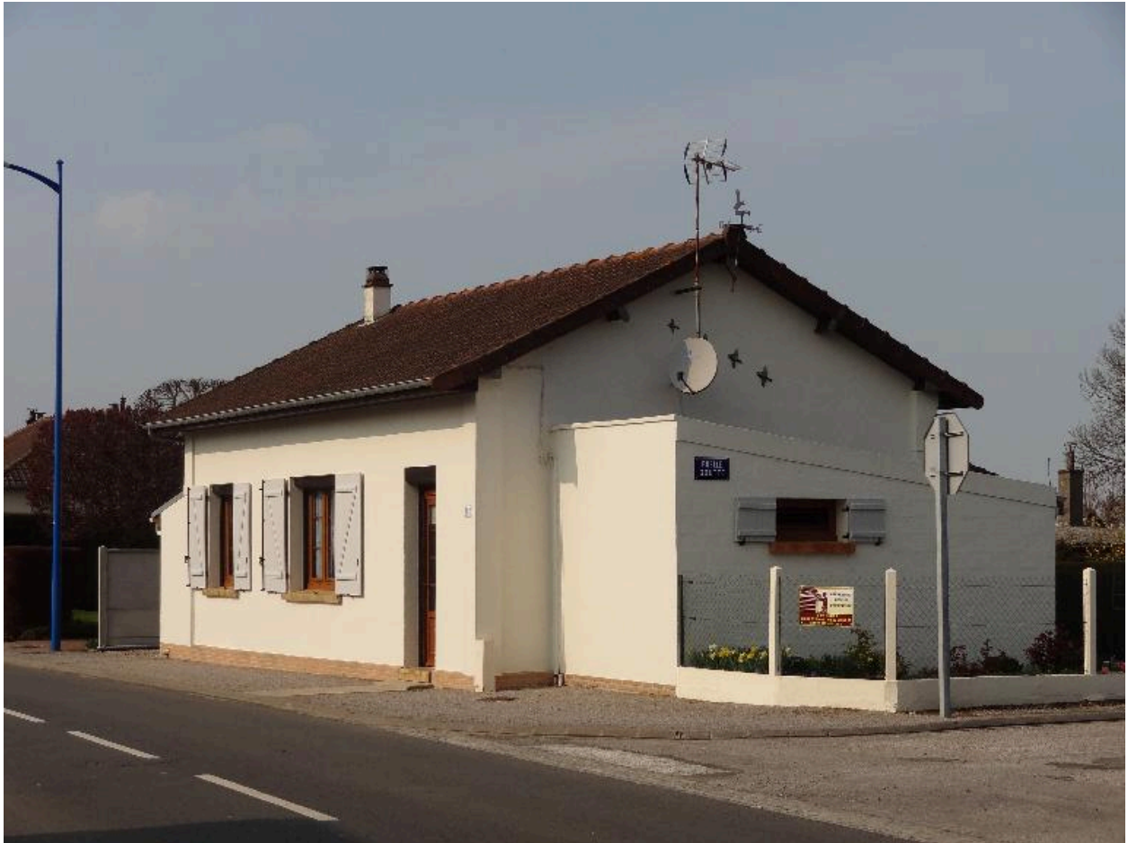
Vue générale depuis le rue.
