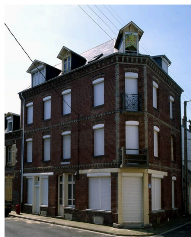
Ancien Hôtel A la Renaissance, au Bourg d'Ault. A. Lasnel architecte. Phot. Marie-Laure Monnehay-Vulliet IVR22_20058001162XA
