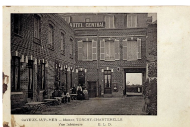
La cour de l'ancien Hôtel Central à Cayeux-sur-Mer. Phot. Monnehay-Vulliet Marie-Laure IVR22_20058000413XAB
