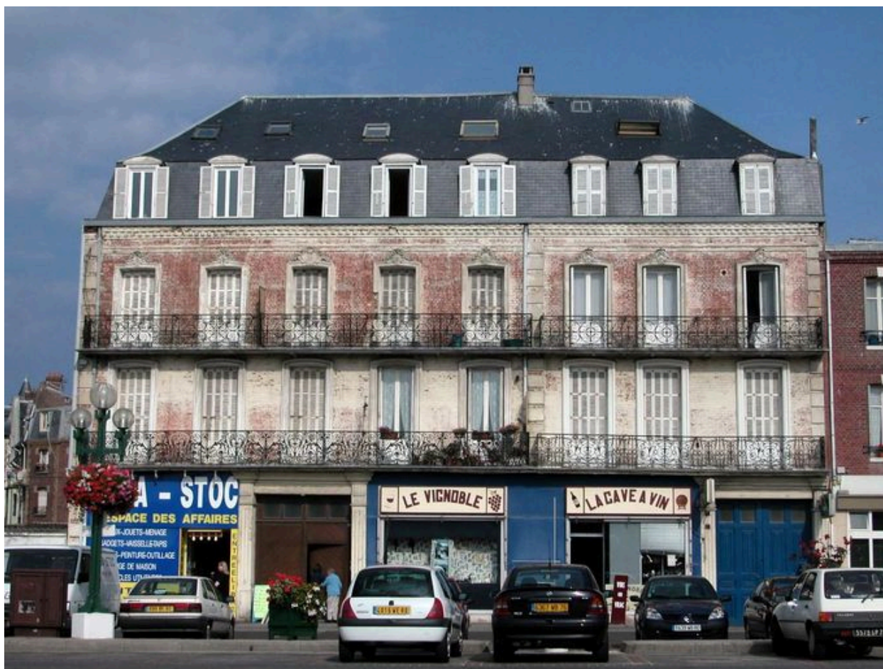
Ancien Hôtel des Bains de Mers-les-Bains.
