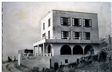
Ancien Hôtel des Hublots, au Bois de Cise. Phot. Monnehay-Vulliet Marie-Laure IVR22_20058000665XAB
