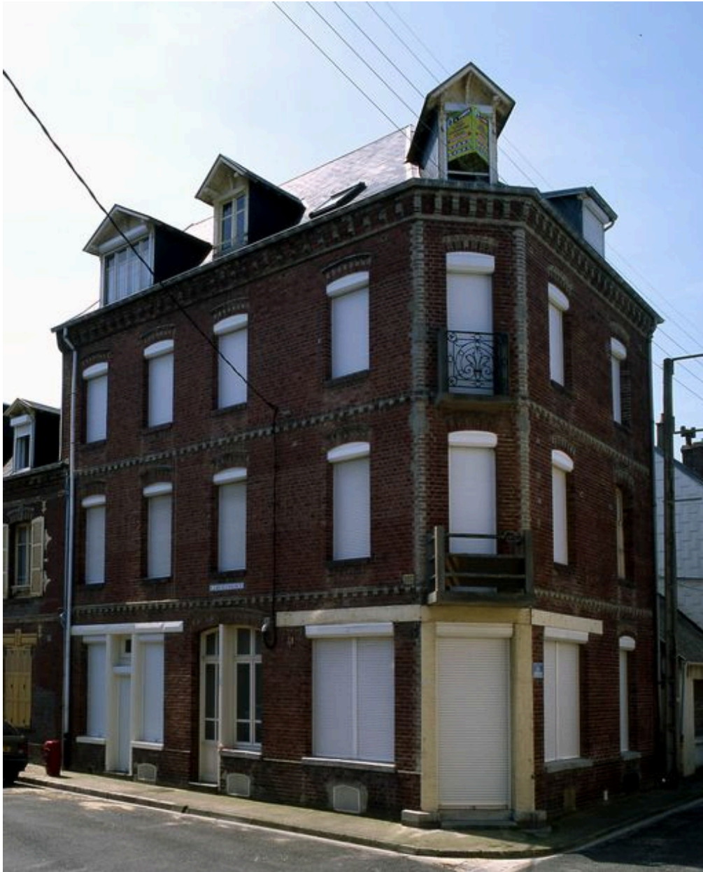
Ancien Hôtel A la Renaissance, au Bourg d'Ault. A. Lasnel architecte.
