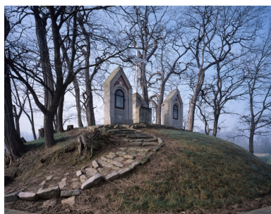
Vue générale du chemin calvaire et son chemin d'accès.
