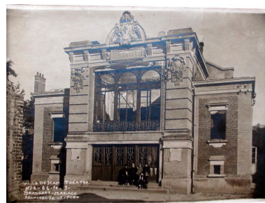
Façade principale, photographie n°1, Brassart-Mariage, 9 octobre 1921 (AD Somme ; 10 R 621). Phot. Gilles-Henri Bailly (reproduction) IVR22_20158005398NUCA
