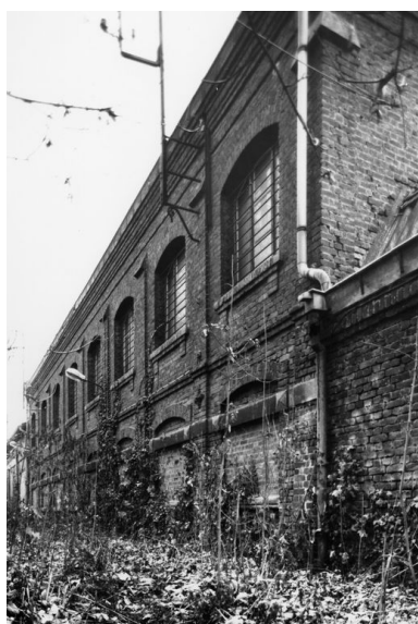
Atelier de fabrication, façade sur le canal des Teinturiers. Phot. Benoît Dufournier IVR22_19898000542Z
