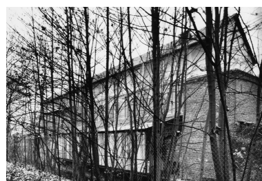
Atelier de la rue Guérard, façade sud sur le canal, vue depuis le sud-est. Phot. Benoît Dufournier IVR22_19898000543Z
