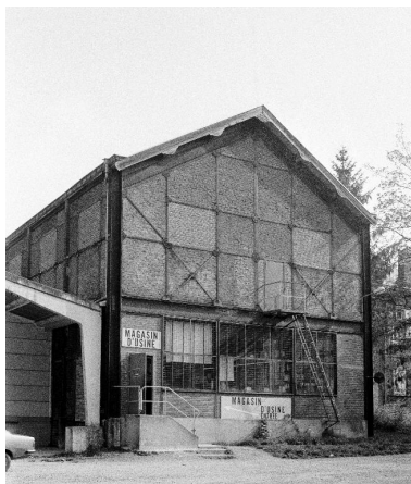
Atelier de fabrication, au sud du canal des Teinturiers, vue depuis le sud). Phot. Benoît Dufournier IVR22_19888000527Z
