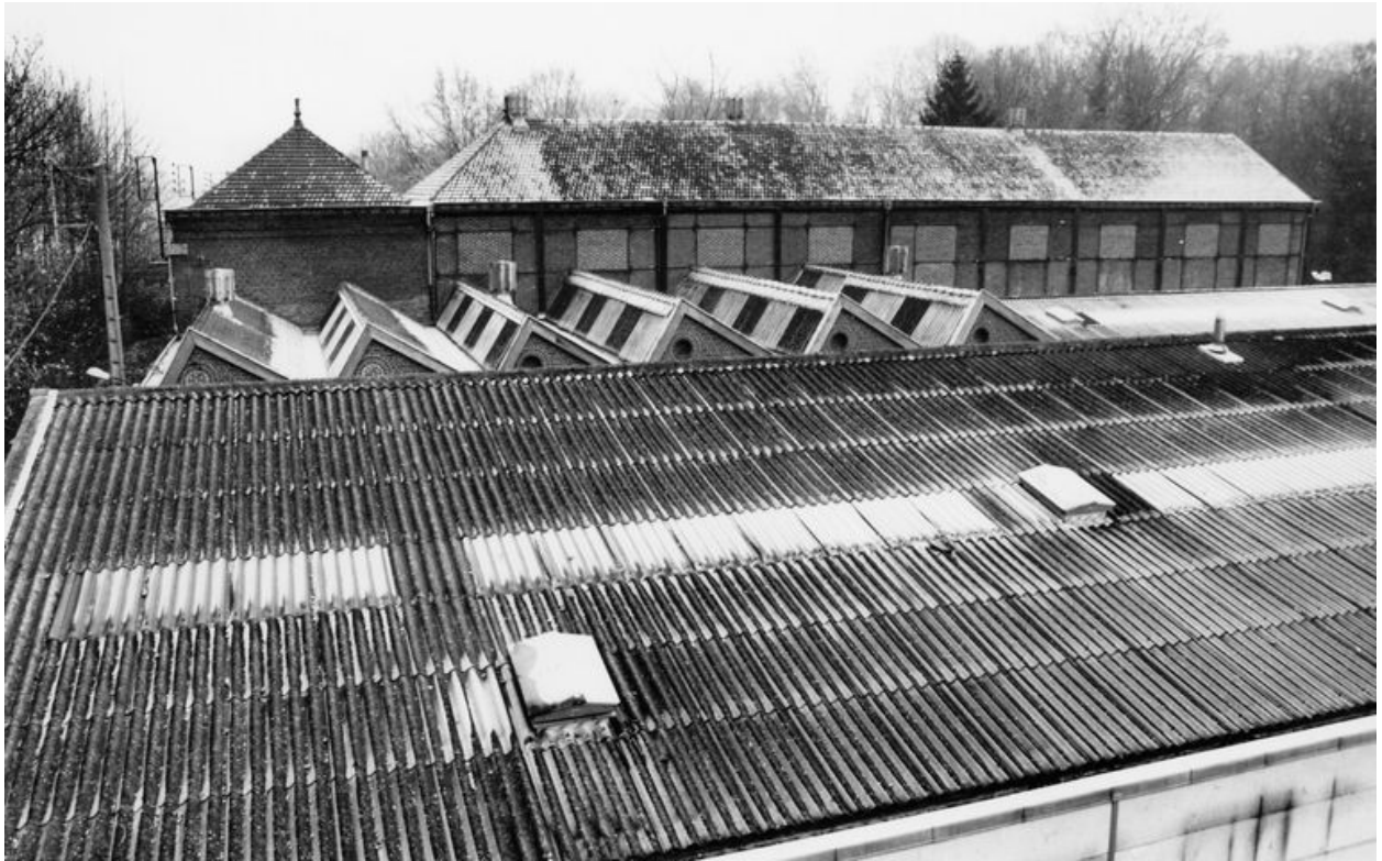
Atelier de fabrication, au sud du canal des Teinturiers, vue depuis le nord-ouest.
