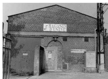
Ancienne chaufferie. Phot. Benoît Dufournier IVR22_19888000530Z
