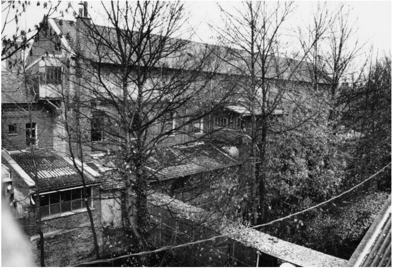
Atelier de la rue Guérard, façade sud sur le canal, vue depuis le sud-ouest.
