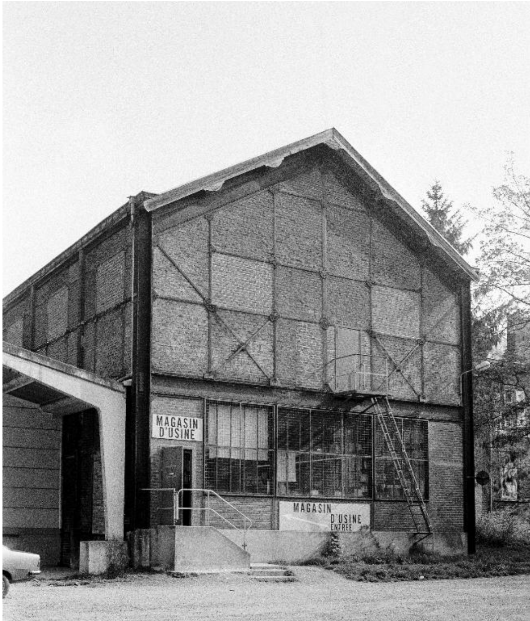
Atelier de fabrication, au sud du canal des Teinturiers, vue depuis le sud).
