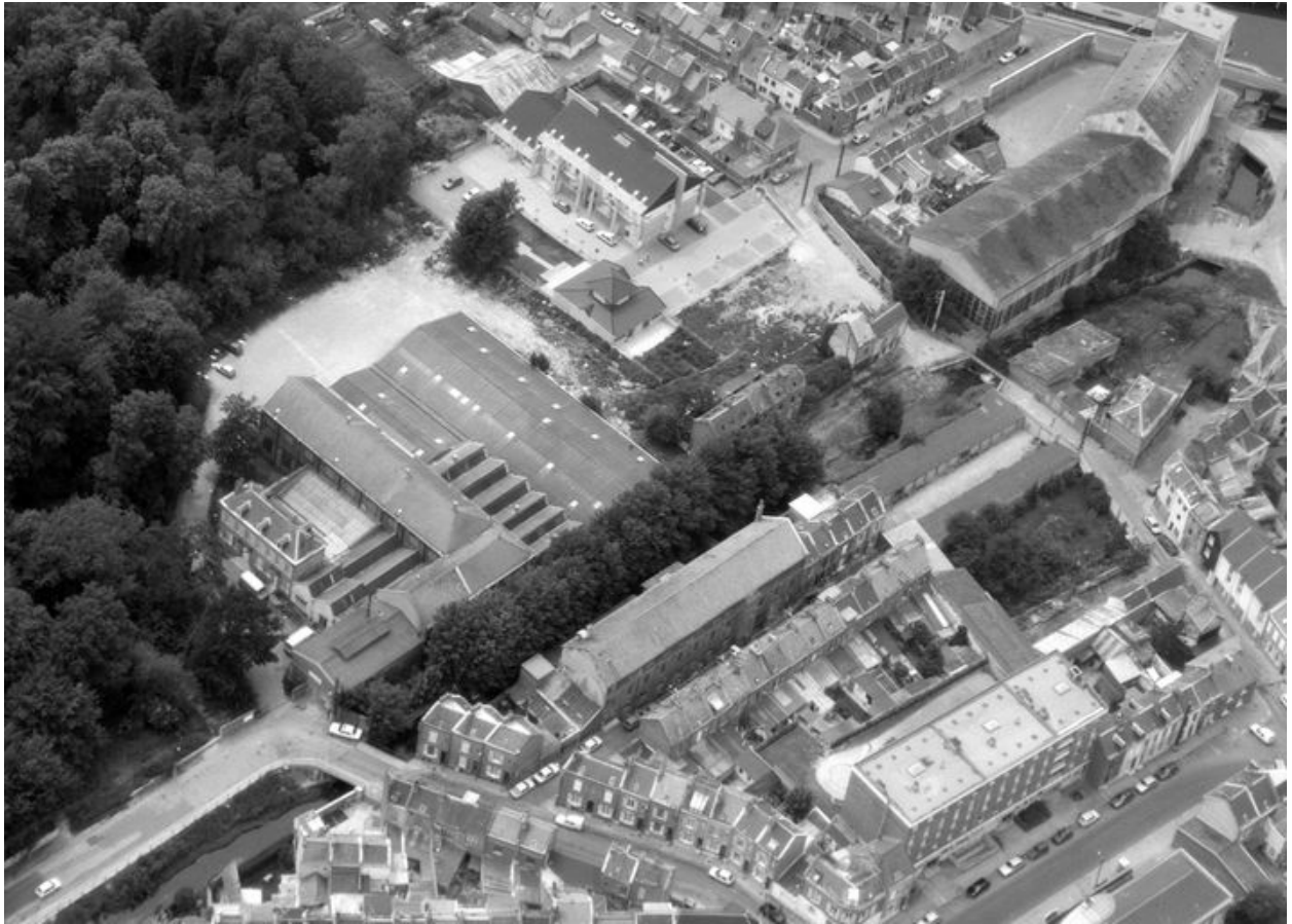
Vue aérienne, flanc nord-est.
