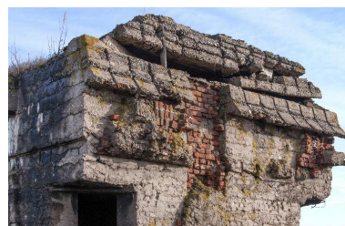
Elévation ouest, détail de l'embrasure d'observation Phot. Jean-Marc Ramette IVR31_20145904955NUCA
