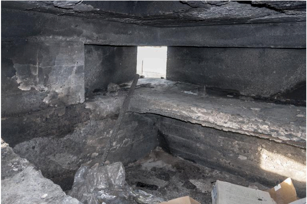
Vue intérieure de la banquette de tir nord et embrasure de tir nord-ouest
