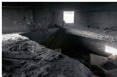
Vue intérieure des banquettes de tir nord et sud. Embrasure de tir nord-ouest Phot. Jean-Marc Ramette IVR31_20145904959NUCA
