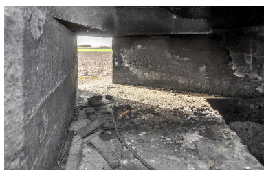
Vue intérieure de la banquette de tir et de l'embrasure sud-ouest de l'édifice. Phot. Jean-Marc Ramette IVR31_20145904960NUCA
