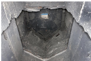
Vue zénithale de l'observatoire casematé. Phot. Pierre Thibaut IVR31_20155901659NUCA
