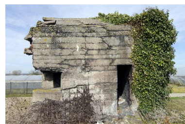
Elévation sud Phot. Jean-Marc Ramette IVR32_20165901487NUCA
