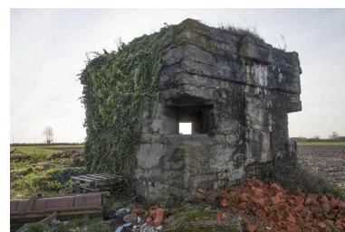
Embrasure de tir située sur l'angle nord-est de l'édifice. Phot. Jean-Marc Ramette IVR31_20145904953NUCA
