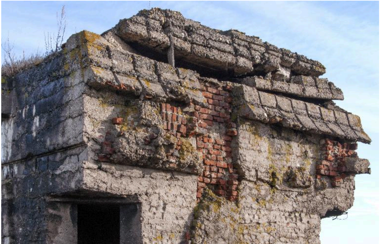
Elévation ouest, détail de l'embrasure d'observation
