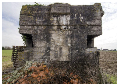
Elévation nord Phot. Jean-Marc Ramette IVR32_20165901485NUCA
