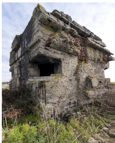
Embrasure de tir situé sur l'angle nord-ouest de l'édifice. Phot. Jean-Marc Ramette IVR32_20165901484NUCA
