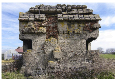
Elévation ouest Phot. Jean-Marc Ramette IVR32_20165901486NUCA
