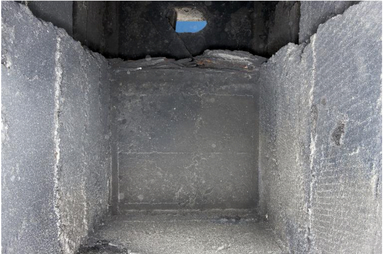
Vue zénithale de l'observatoire casematé. Loge de l'observateur
