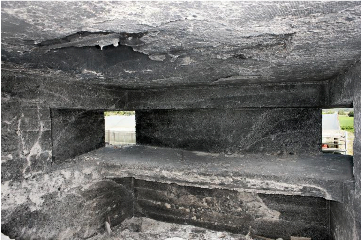
Vue intérieure de la banquette nord et des embrasures de tir nord-est et nord-ouest
