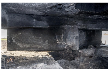
Vue intérieure des embrasures de tir nord-est et sud-ouest Phot. Jean-Marc Ramette IVR31_20145904963NUCA
