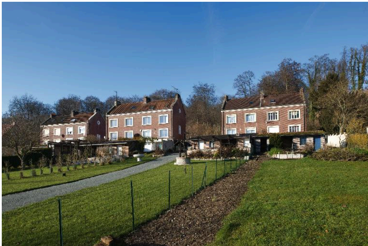
Vue des façades sud des logements, côté jardin.
