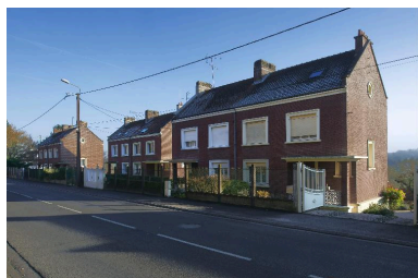
Vue des façades sur rue des logements. Phot. Thierry Lefébure IVR22_20138000536NUC2A
