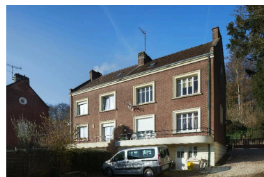
Façade postérieure d'une maison (55-57, rue Pierre-Légrand) Phot. Thierry Lefébure IVR22_20138000537NUC2A
