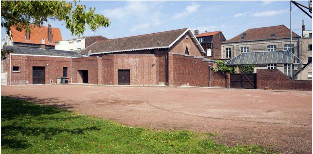
Façade côté sud.
