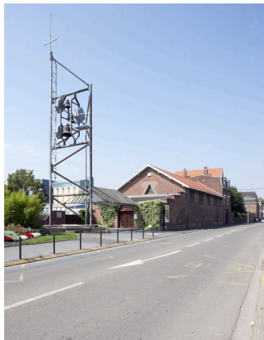
Façade côté nord et clocher. Phot. Pierre Thibaut IVR31_20155901001NUCA
