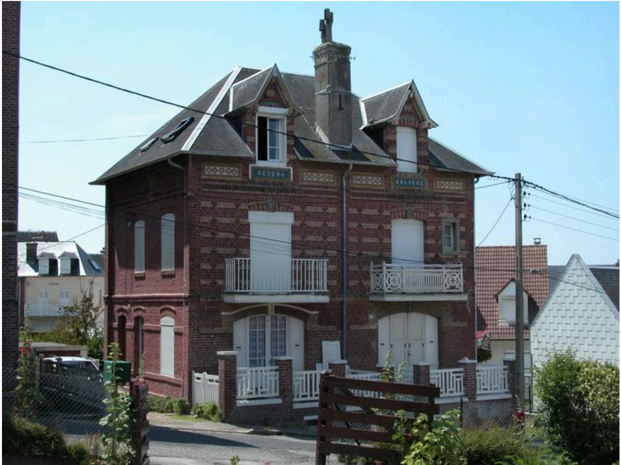
Vue d'ensemble depuis la rue.
