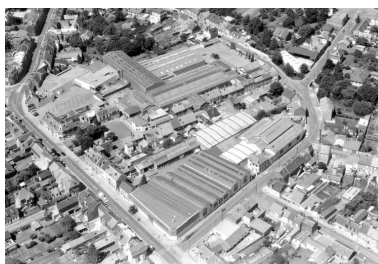
Vue aérienne, flanc sud-est. Phot. Phot'R IVR22_19888001226P
