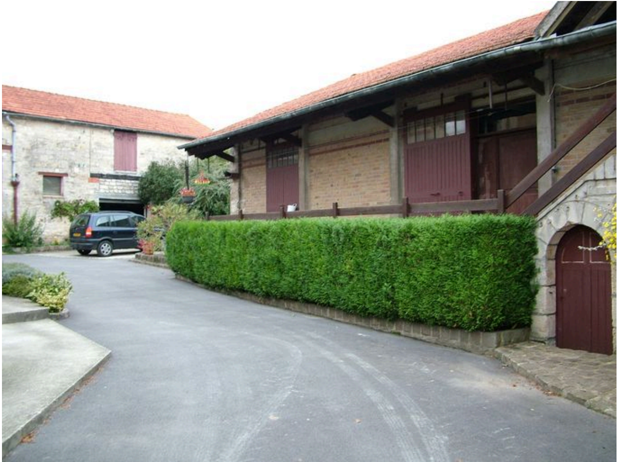
Vue du bâtiment situé à droite de la cour.
