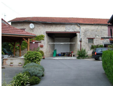
Vue de la grange en fond de propriété. Phot. Irwin Leullier IVR22_20050201021NUCA
