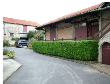
Vue du bâtiment situé à droite de la cour. Phot. Irwin Leullier IVR22_20050201022NUCA
