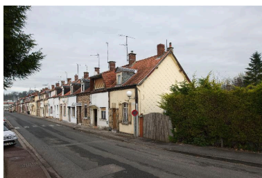
Vue d'ensemble de la cité ouvrière Saint-Gaston. Phot. Thierry Lefébure IVR22_20138000522NUC2A
