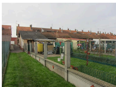
Venelle de séparation des blocs de logements, vue depuis les jardins à l'arrière. Phot. Bertrand Fournier IVR22_20138016089NUC2A
