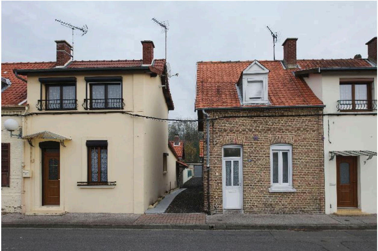
Venelle de séparation entre deux groupes de logements de la cité Saint-Gaston.
