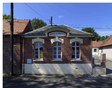
Vue de la façade antérieure. Phot. Thierry Lefébure IVR22_20158000566NUC2A
