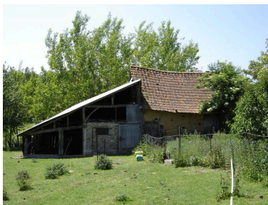
Abri situé au fond de la pâture. Phot. Inès Guérin IVR22_20058005814NUCA
