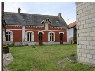
Vue partielle du logis depuis la cour. Phot. Inès Guérin IVR22_20058005808NUCA
