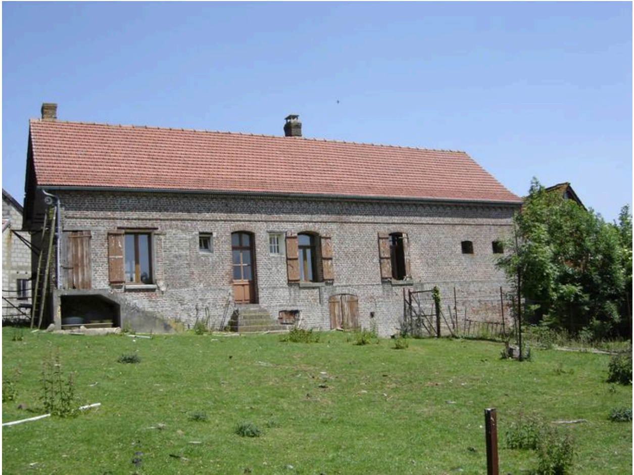
Vue postérieure du logis.
