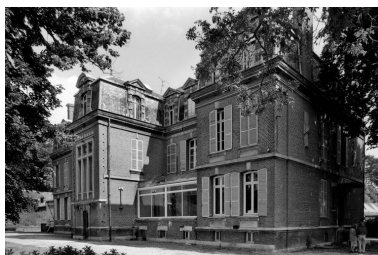
Elévation postérieure du logis, en 1991. Phot. Benoît Dufournier IVR22_19918000061Z
