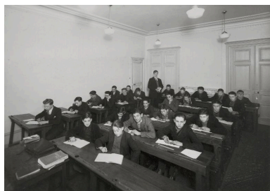
Salle de formation installée dans l'ancien château Rouge, 1937. Phot. Thierry Lefébure IVR22_20128000525NUC2A
