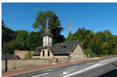
Pigeonnier de la basse-cour du château depuis la rue.
