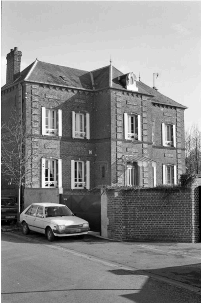
Vue de la maison de contremaître située rue Jacob.
