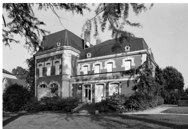
Vue de la maison patronale depuis le parc. Phot. Pierre-Yves Brest IVR22_19990206177Z
