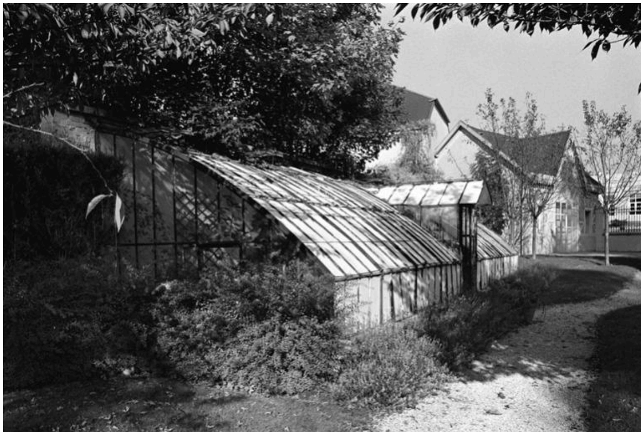
Vue d'ensemble de la serre.
