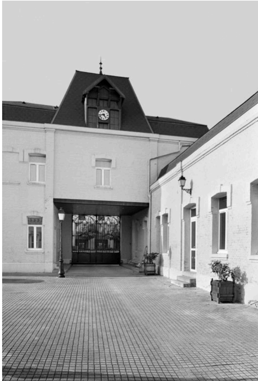
Vue d'ensemble du porche d'entrée de la maison patronale.
