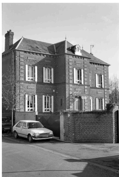
Vue de la maison de contremaître située rue Jacob. Phot. Pierre-Yves Brest IVR22_19990207084Z
