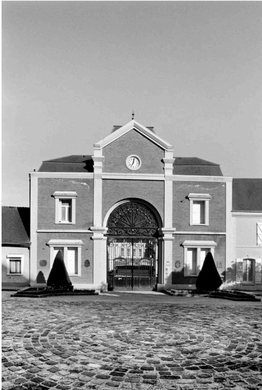
Vue de l'entrée de l'usine, depuis la place de l'hôtel-Dieu (après la transformations de 1989).
