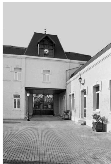
Vue d'ensemble du porche d'entrée de la maison patronale. Phot. Pierre-Yves Brest IVR22_19990206197Z
