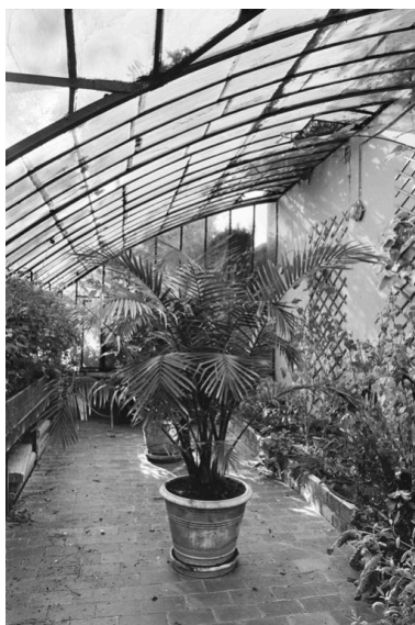
Vue intérieure de la serre. Phot. Pierre-Yves Brest IVR22_19990206184Z
