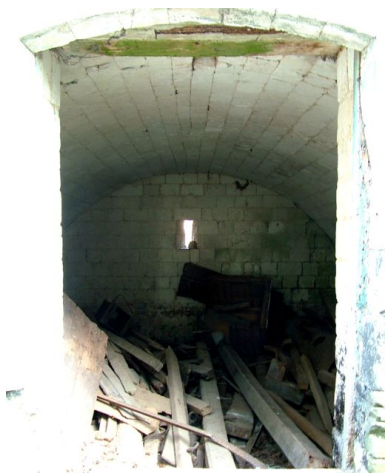
Porte et voûte en berceau du cellier dans le soubassement du colombier.
