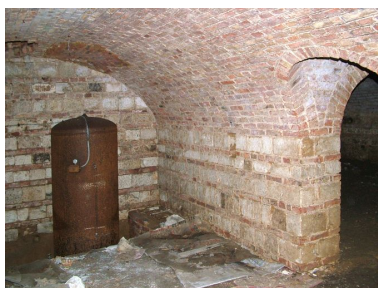
Pièce voûtée en sous-sol de la maison du jardinier.
