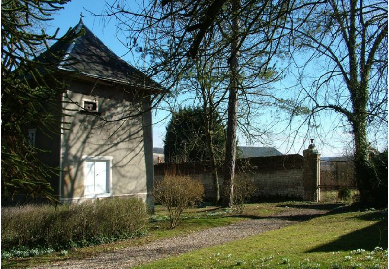
Colombier et portail de l'ancienne cour vers le potager à l'est.
