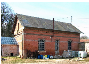
Ferme du château : ancien logement.
