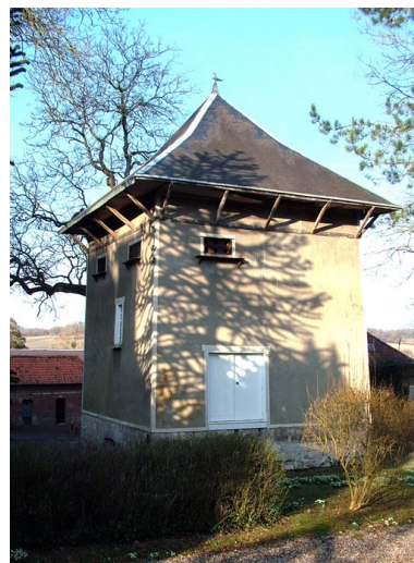
Colombier, vue avant. Phot. Frédéric Fournis IVR22_20108001147NUCA
