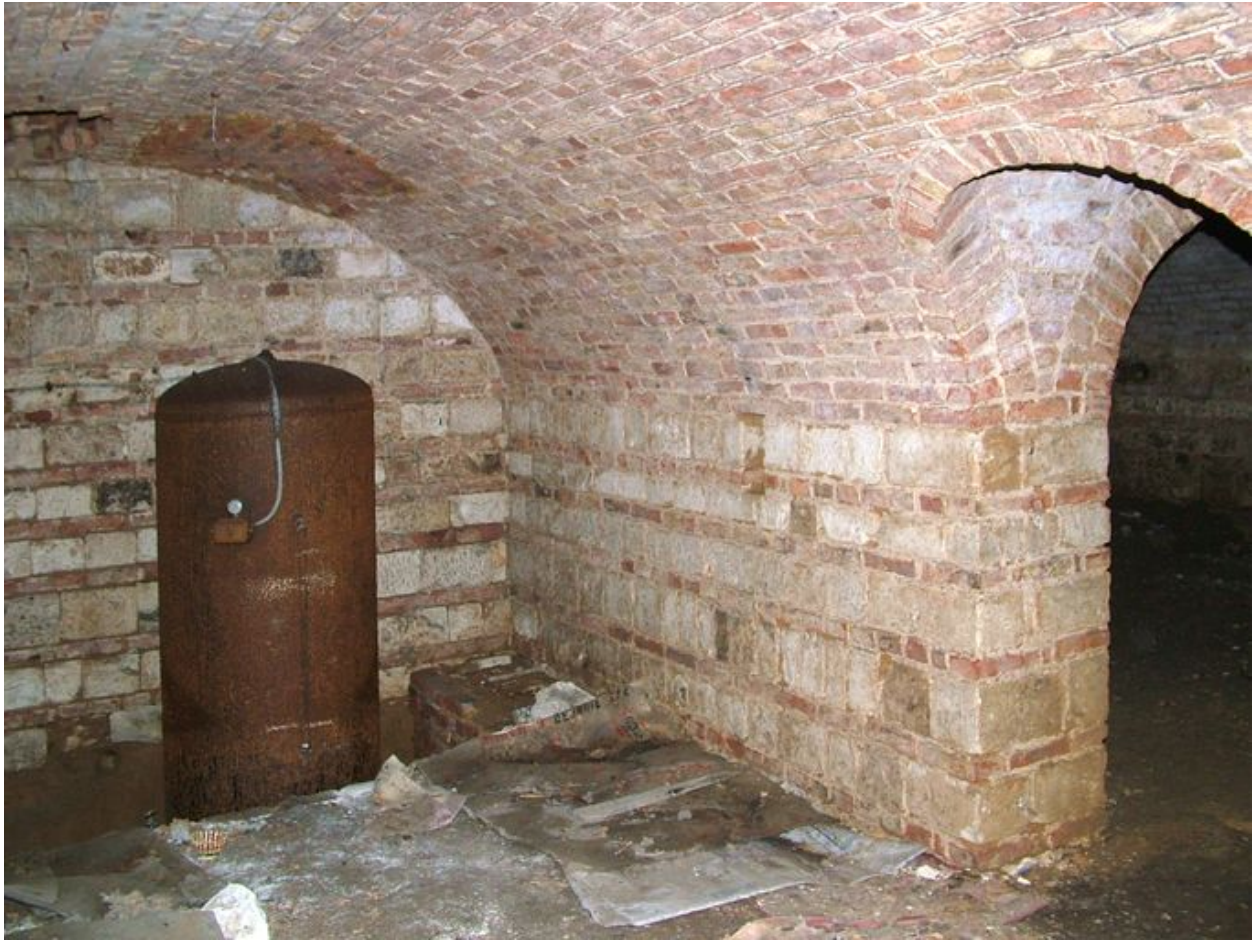
Pièce voûtée en sous-sol de la maison du jardinier.
