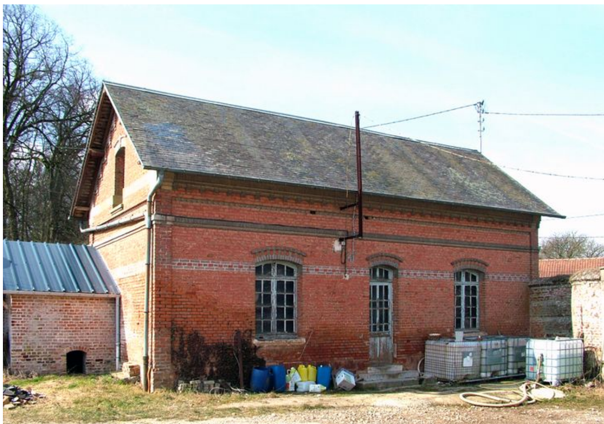
Ferme du château : ancien logement.
