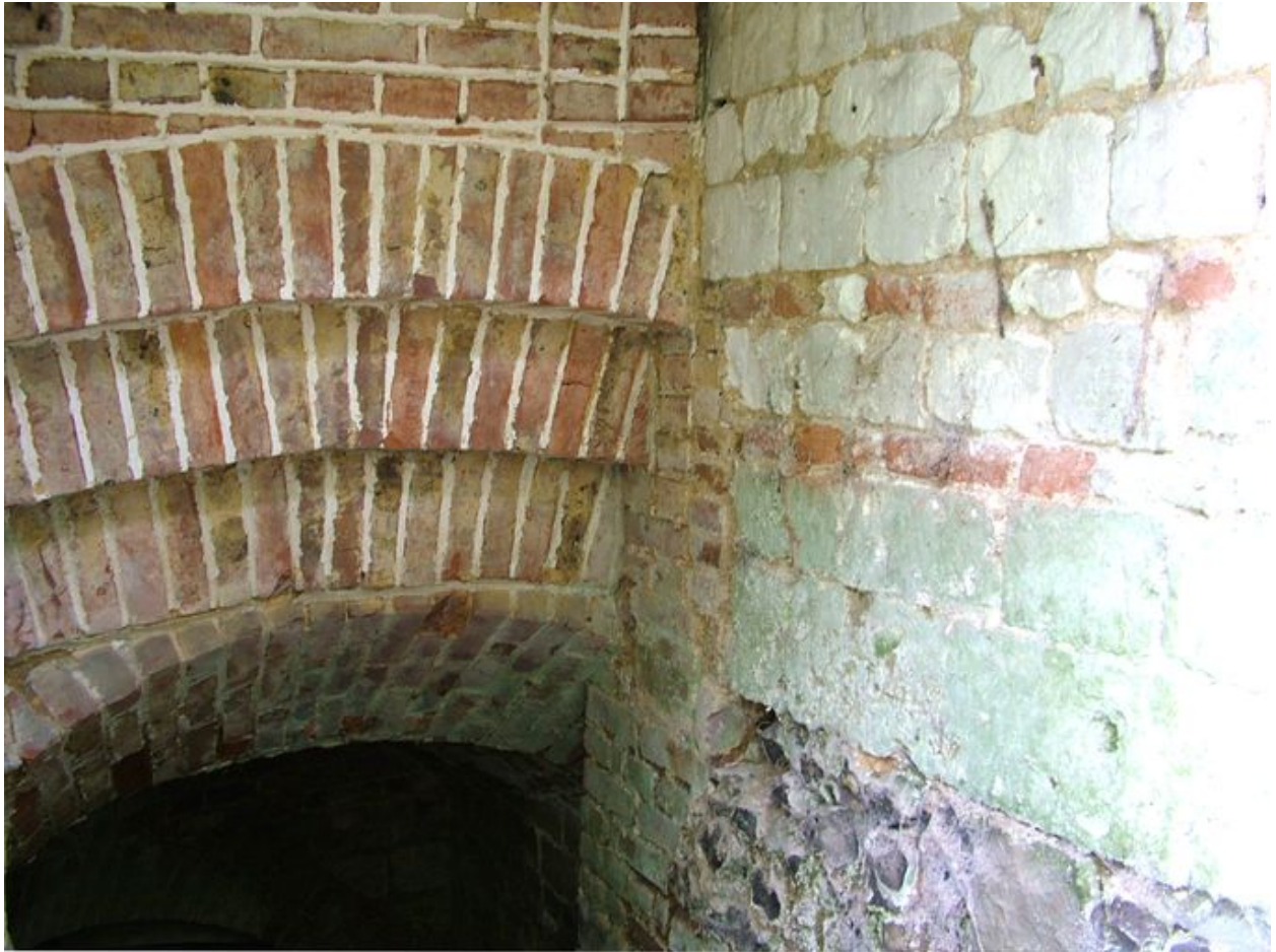
Voûte à ressaut de l'escalier d'accès au sous-sol de la maison du jardinier.
