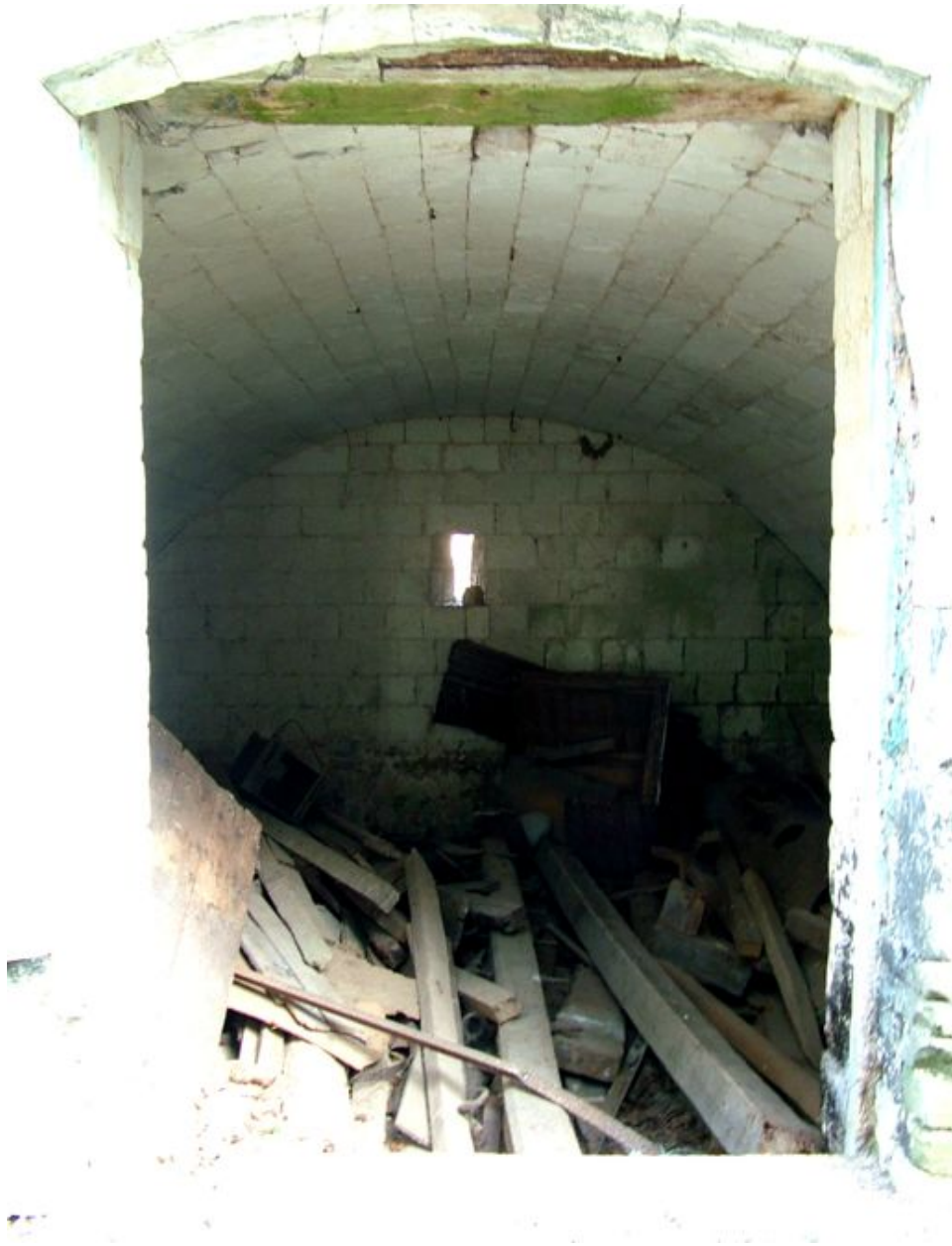
Porte et voûte en berceau du cellier dans le soubassement du colombier.
