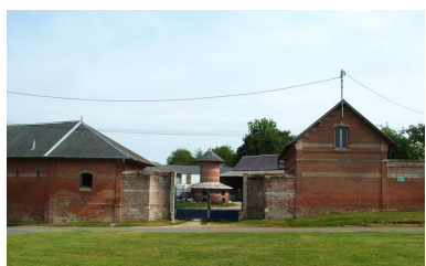
Ferme du château : étable et logement entourant le portail sur la place.
