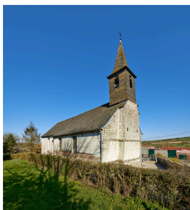
Vue du clocher depuis le sud-ouest. Phot. Thierry Lefébure IVR32_20236200220NUCA
