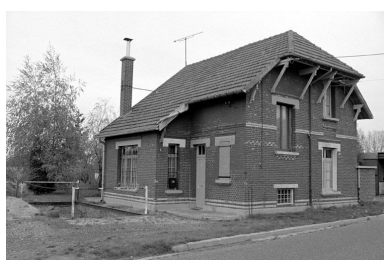
Conciergerie, élévation antérieure Phot. Francis Dubuc IVR22_19908001240Z
