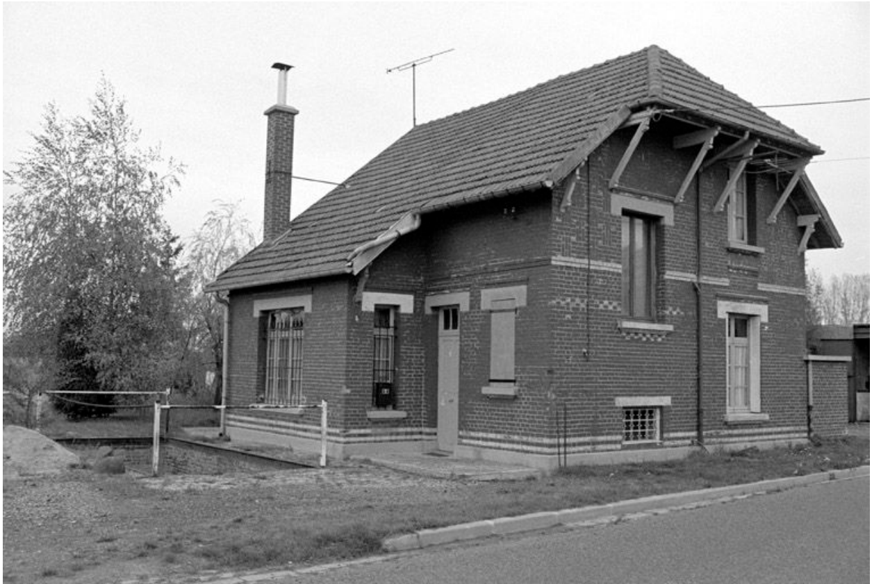
Conciergerie, élévation antérieure
