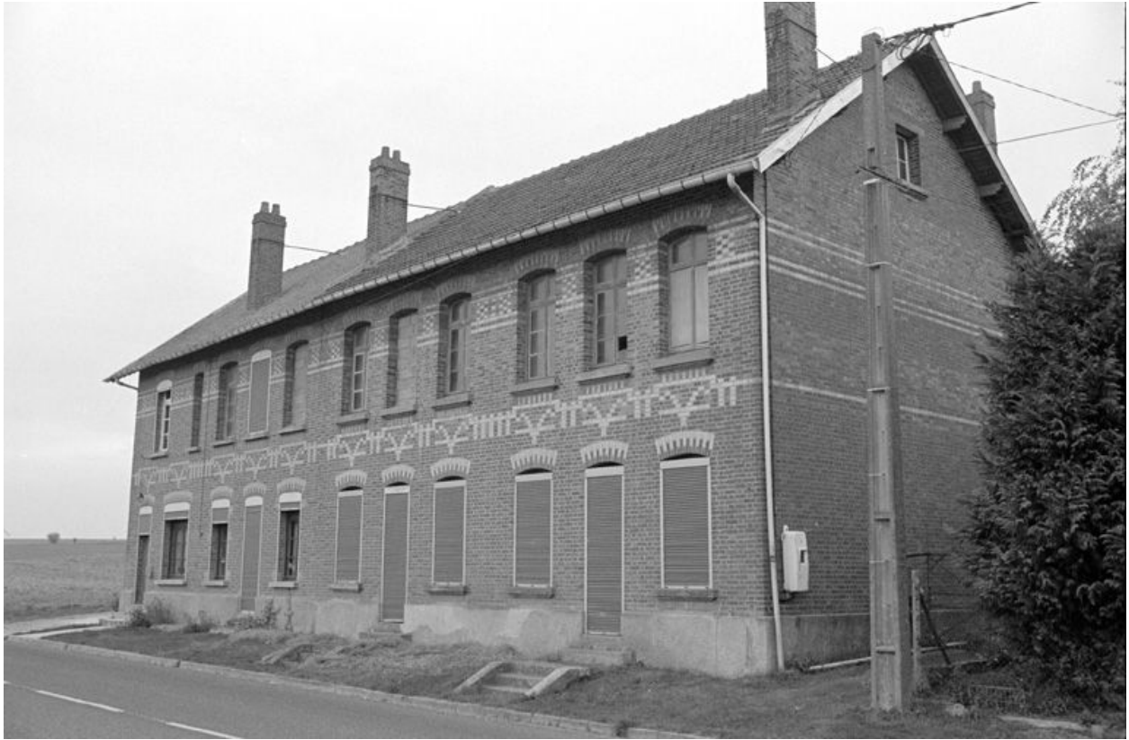
Logement d'ouvriers, élévation antérieure
