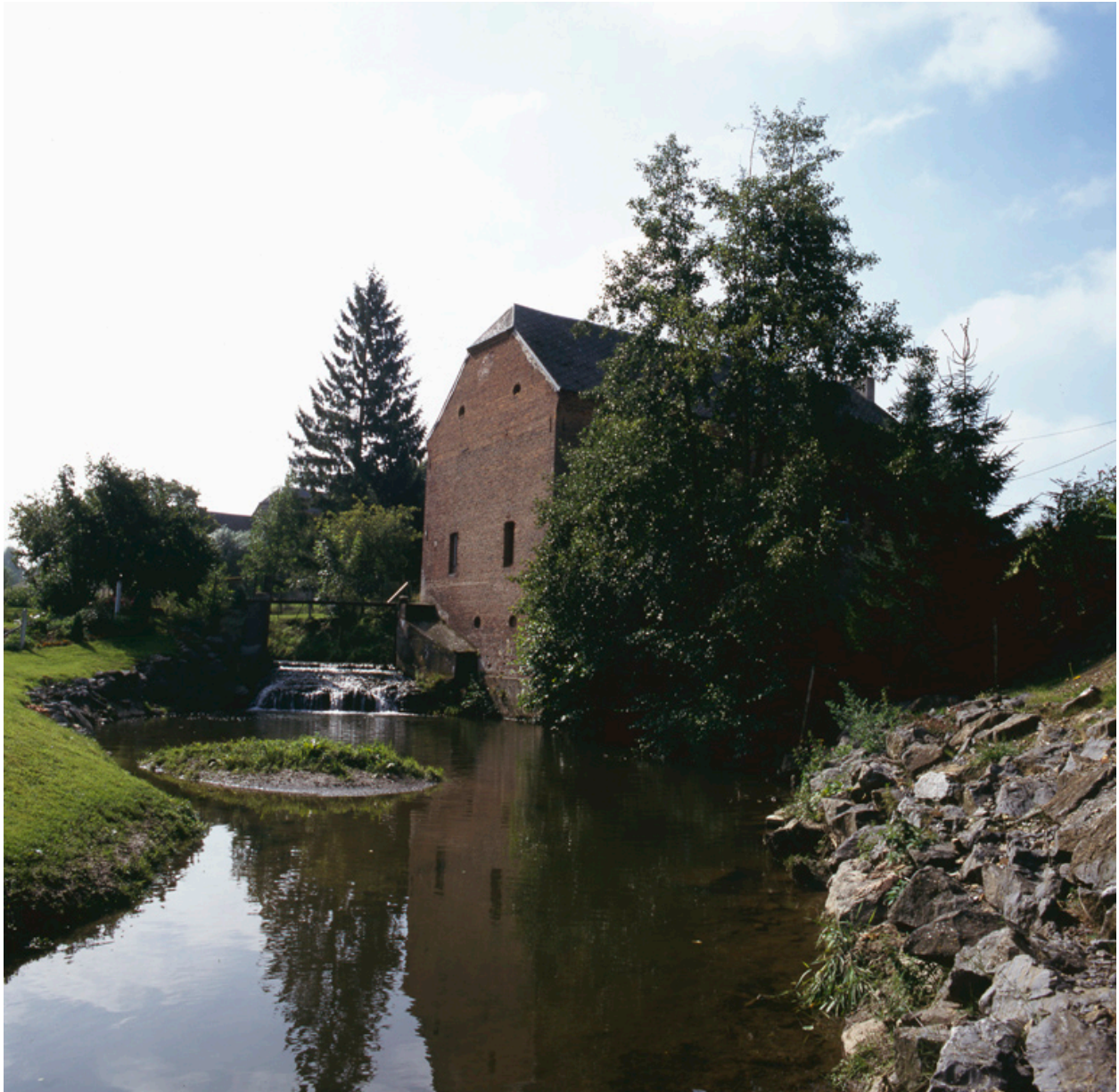
Vue de situation depuis le Noirieux.
