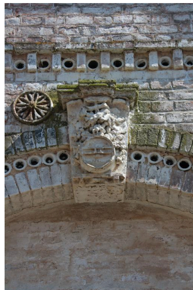
Détail de la clé de voûte de l'entrepôt du marchand de vins. Phot. Romain Grimaud IVR22_20128005257NUC2A
