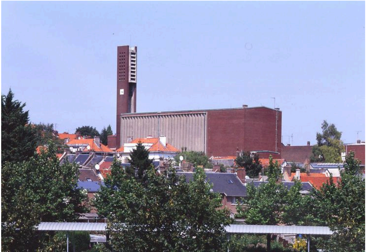
Vue de situation.
