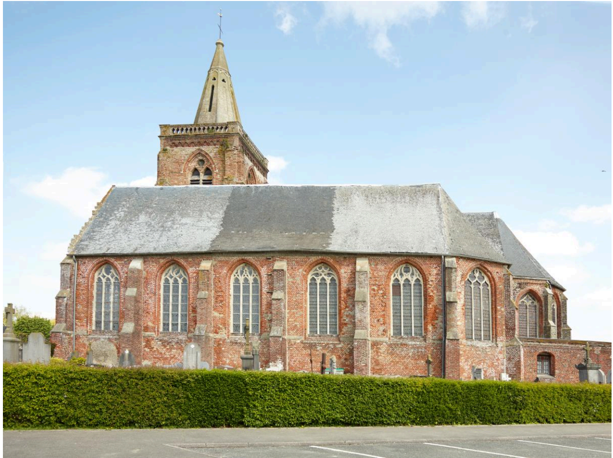
Vue générale depuis le sud.
