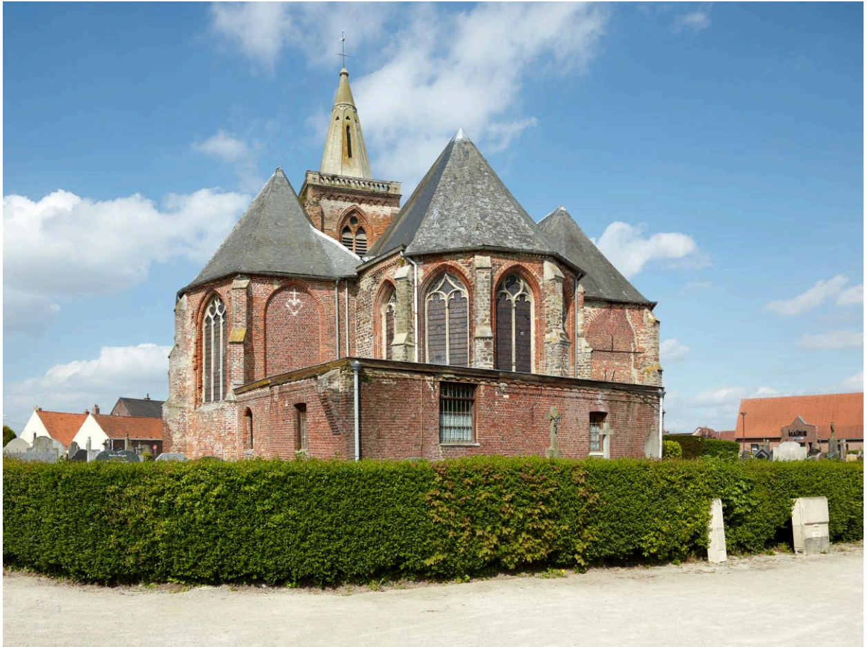
Vue générale depuis l'est.
