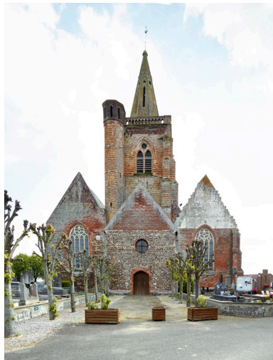
Vue générale depuis l'ouest. Phot. Delphine Volto-Jourdan IVR32_20225900365NUCA
