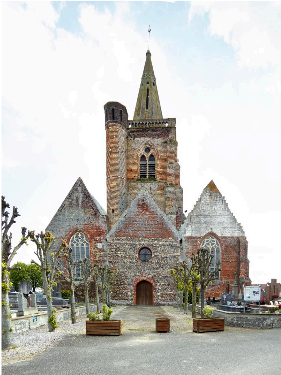
Vue générale depuis l'ouest.
