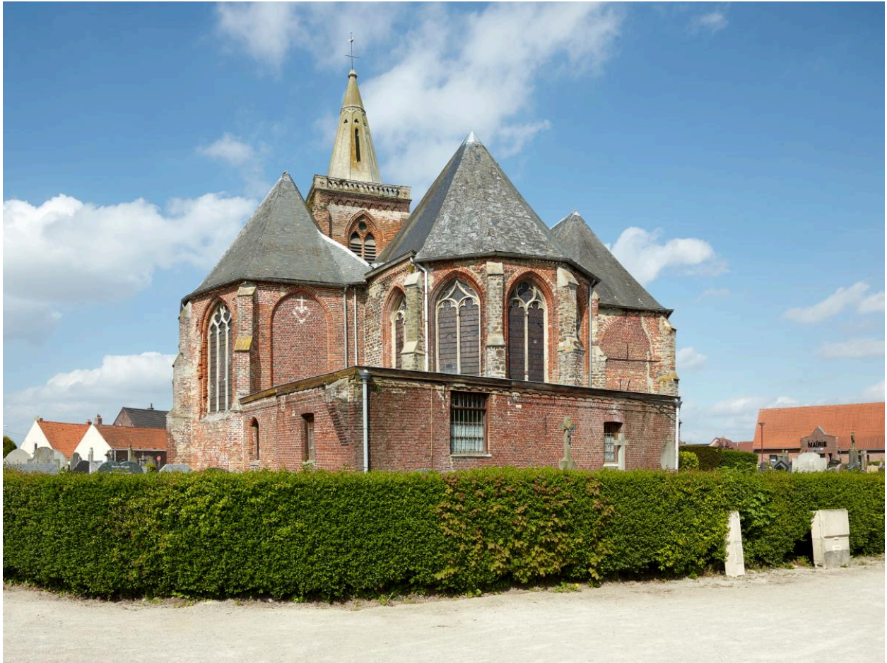
Vue générale depuis l'est.
