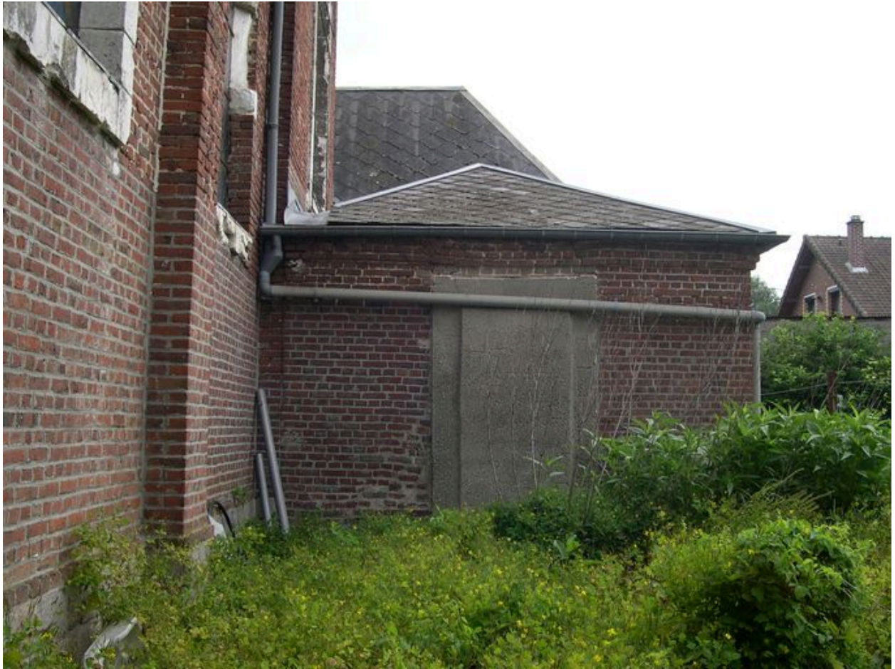
Ancien accès à la sacristie depuis le presbytère.
