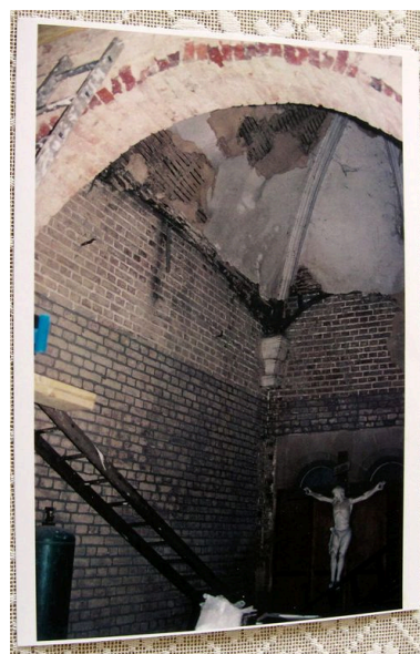
Les voûtes de la sacristie avant travaux (AP). Phot. Isabelle Barbedor IVR22_20068010293NUCA
