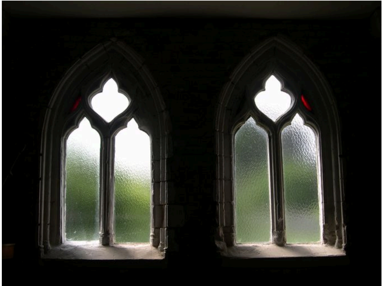
Baies en rempli dans la sacristie (mur sud).
