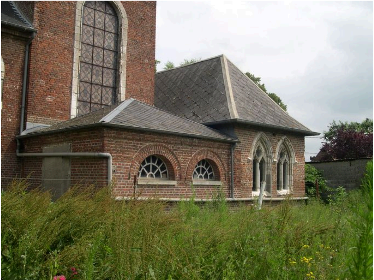
Vue des sacristies depuis le sud-ouest.
