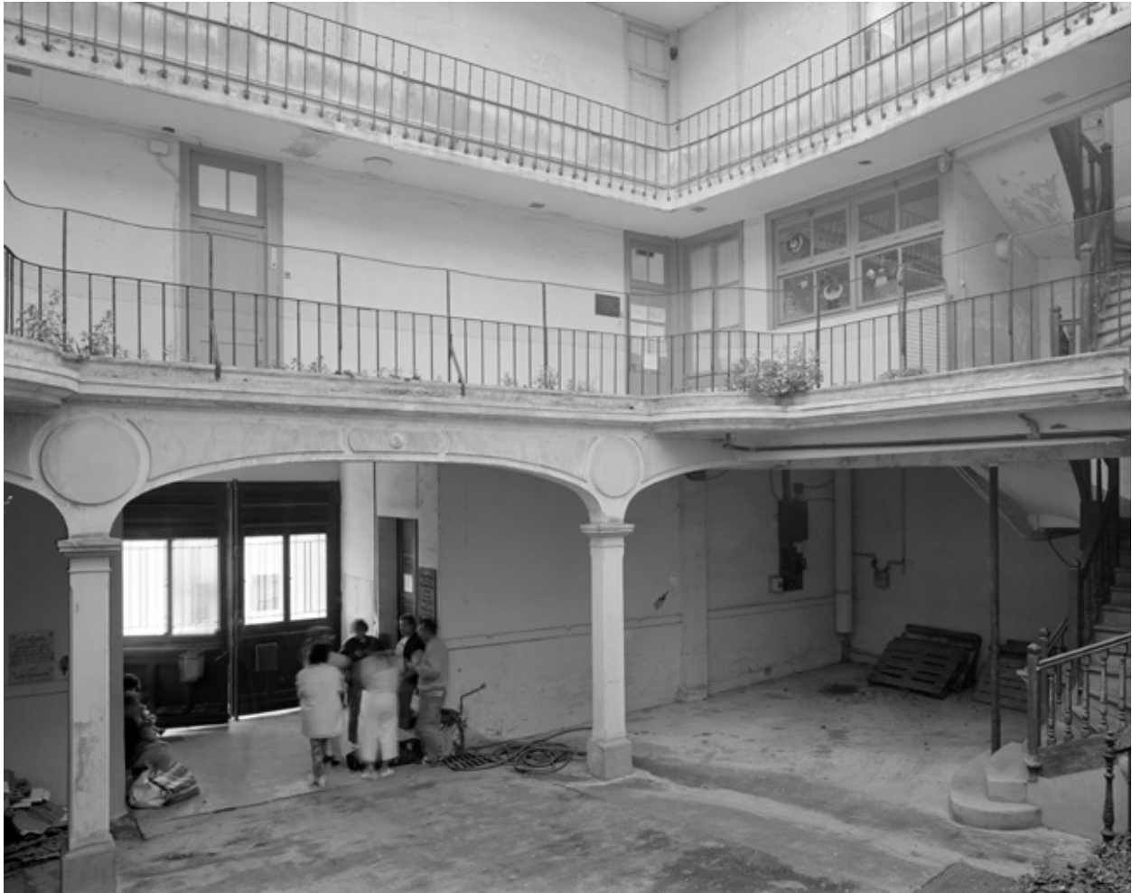
Elévation sur la cour.
