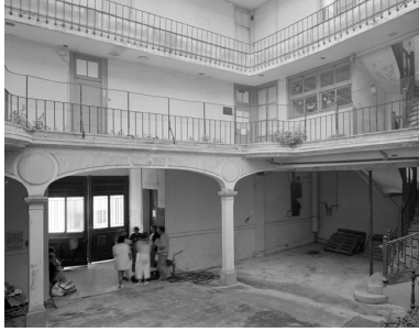
Elévation sur la cour. Phot. Thierry Lefébure IVR22_19940201130V
