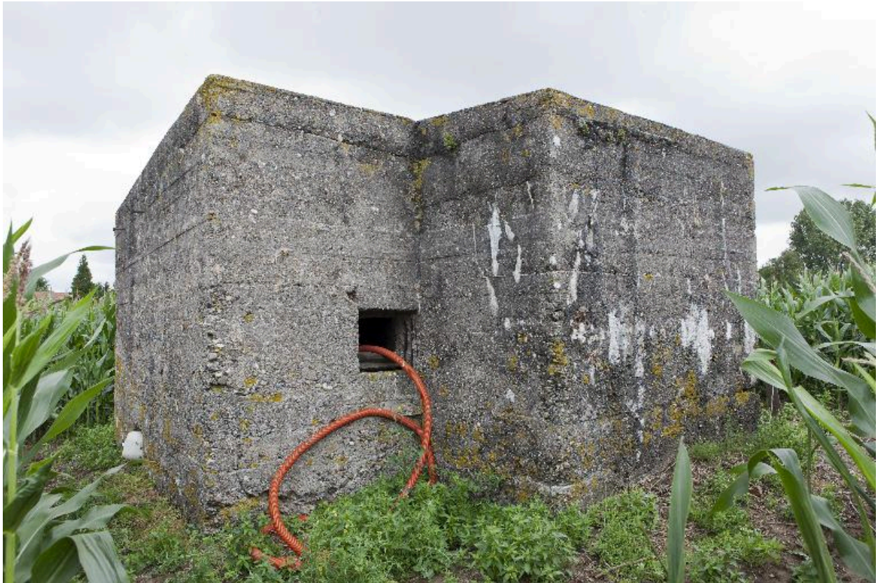
Vue de trois-quarts vers le nord-est
