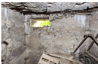
Vue intérieure, vers l'est Phot. Jean-Marc Ramette IVR31_20145905480NUCA
