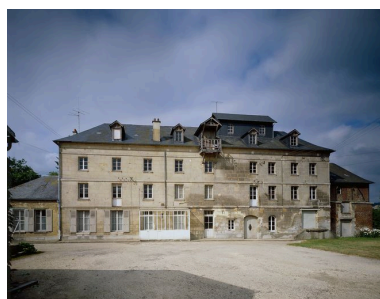
Élévation antérieure. Phot. Fabrice Charrondière IVR22_19866000159VA
