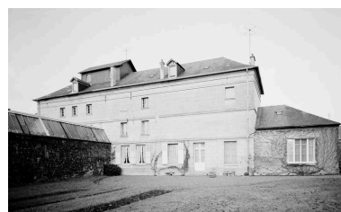
Élévation postérieure. Phot. Fabrice Charrondière IVR22_19856001565V
