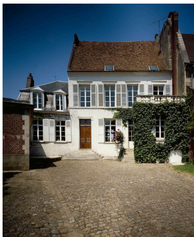
Elévation antérieure sur cour. Phot. Fabrice Charrondière IVR22_19866000107VA
