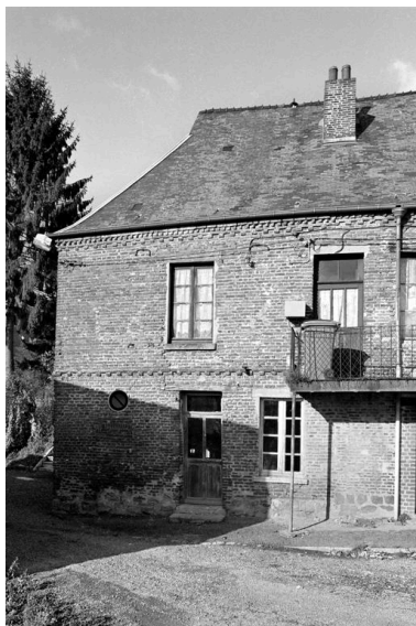
Vue de la façade méridionale, datée de 1663. Phot. Pierre-Yves Brest IVR22_19990207151Z
