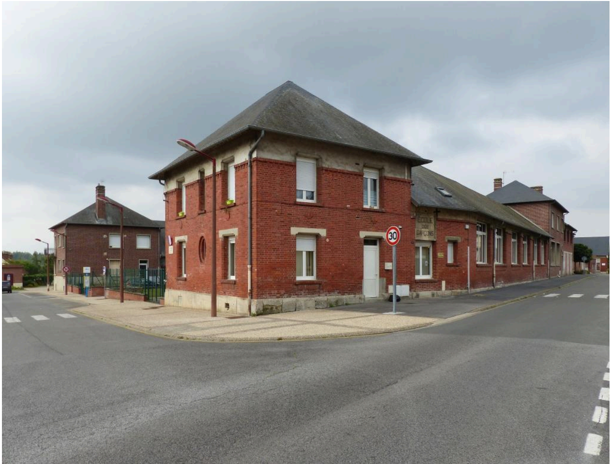
Le groupe scolaire de Quessy-Centre.
