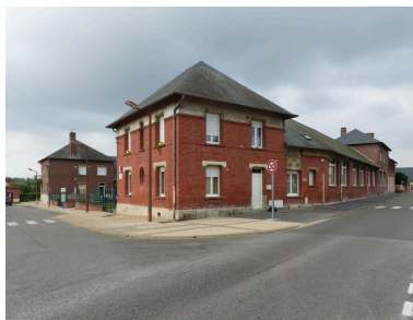
Le groupe scolaire de Quessy-Centre. Phot. Isabelle Barbedor IVR32_20210205120NUCA
