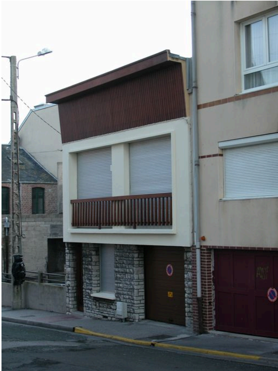
Maison, rue Maurice-Dupont (1982 AE 686).
