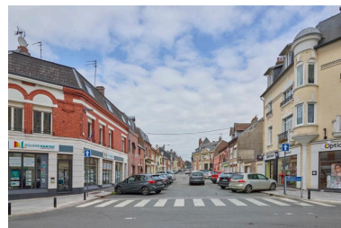
Vue générale orientée ouest - est depuis la rue de Péronne. Phot. Hubert Bouvet IVR32_20196200467NUC4A
