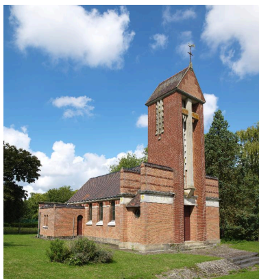
Vue de trois-quarts. Phot. Marie-Laure Monnehay-Vulliet IVR22_20158000684NUC2A
