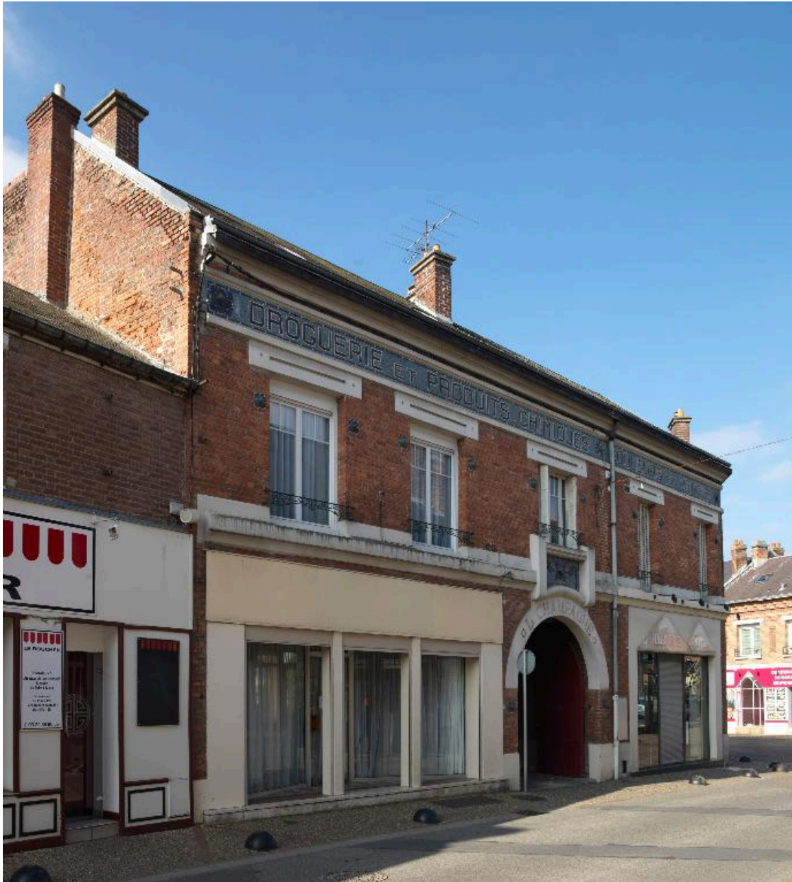
Vue générale, depuis le sud.
