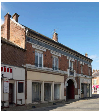
Vue générale, depuis le sud.
