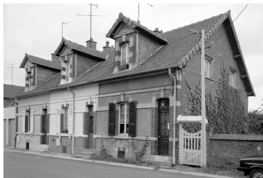
Elévation antérieure. Phot. Jean-Michel Perrin IVR22_19856000965X
