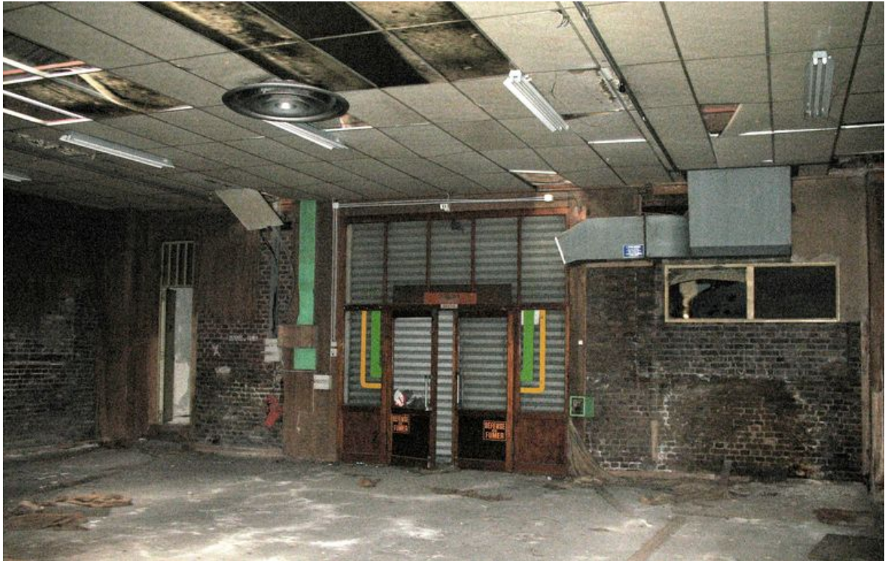
Mur pignon nord-est depuis l'intérieur.
