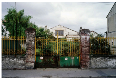
Entrée de l'usine de matériel d'équipement industriel Falque. Phot. Thierry Lefébure IVR22_20076000104XA
