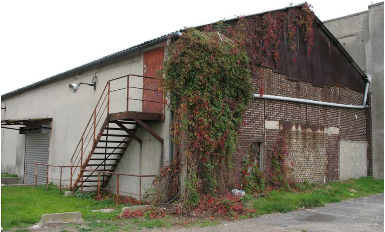
Mur pignon sud-ouest de l'usine de matériel d'équipement industriel.
