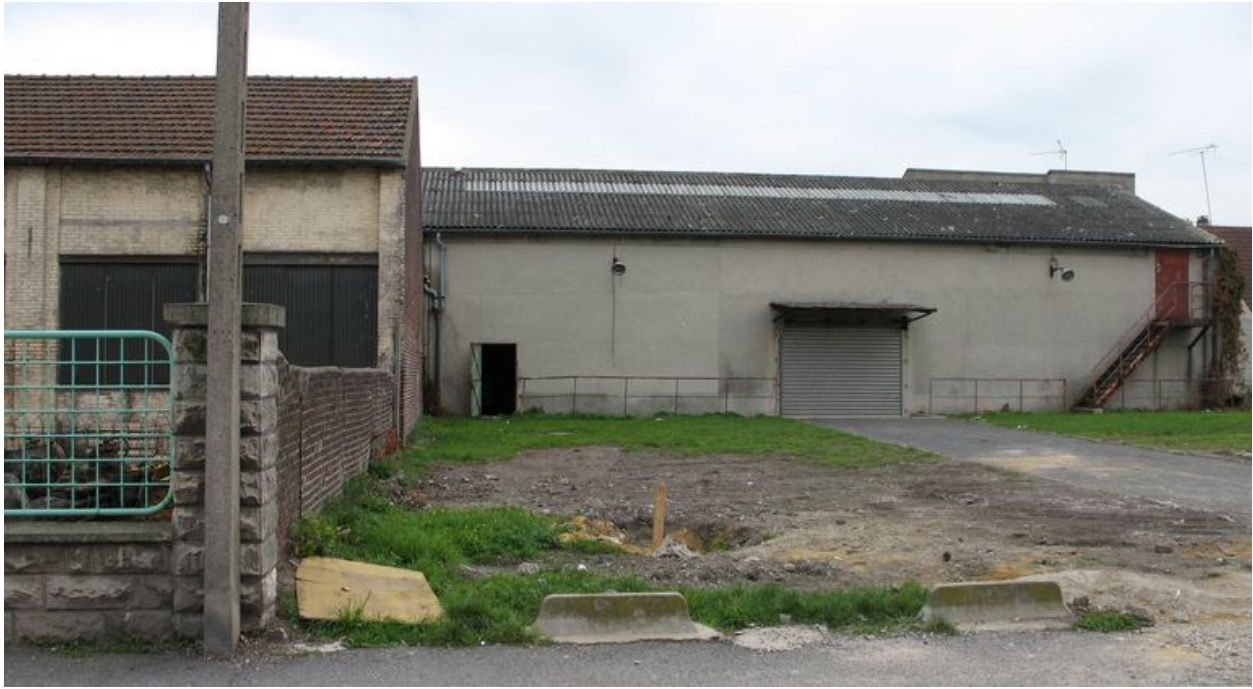
Façade nord-ouest remaniée.
