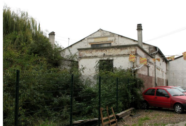
Le bâtiment de l'ancienne usine de matériel d'équipement industriel depuis la rue de Gournay. Phot. Clarisse Lorieux IVR22_20066005157NUCA
