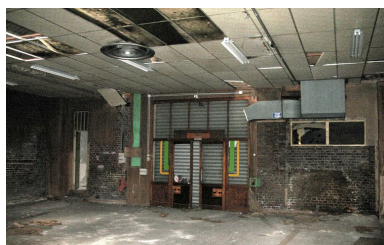
Mur pignon nord-est depuis l'intérieur. Phot. Clarisse Lorieux IVR22_20066005163NUCA
