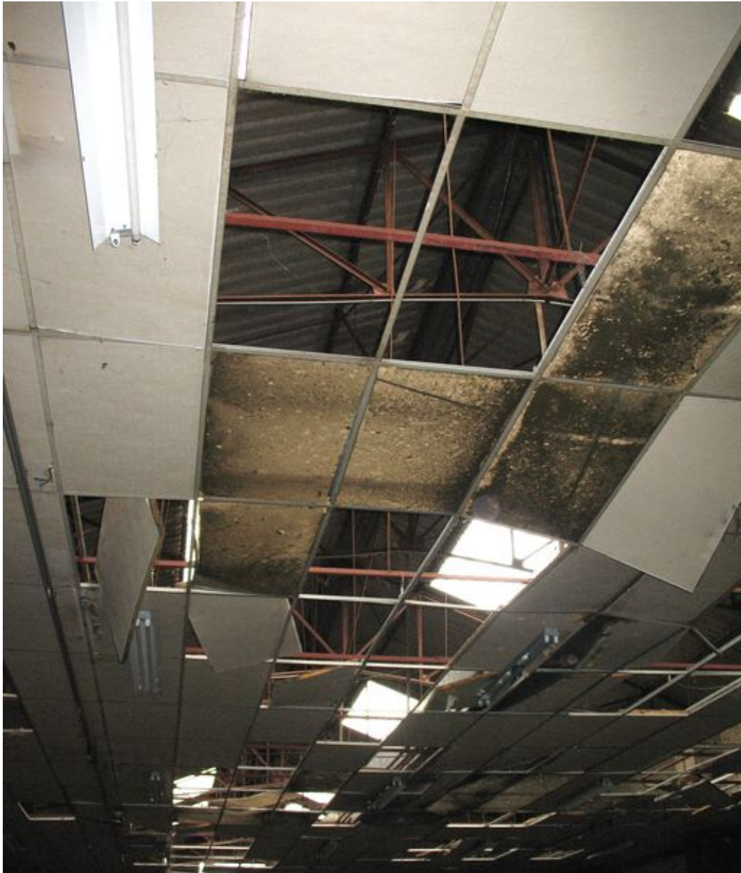
Le faux-plafond et la charpente métallique.
