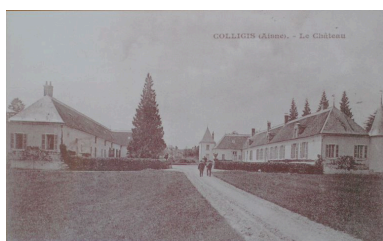
Vue de l'ancien édifice (coll. part). Phot. Leullier Irwin IVR22_20050200671NUCAB
