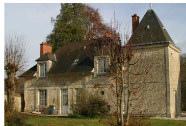
Vue du bâtiment en retour d'angle. Phot. Inès Guérin IVR22_20030202398NUCA
