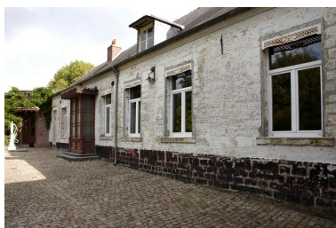
Vue de l'élévation sur cour du bâtiment abritant les pièces de réception. Phot. Pierre Thibaut IVR31_20095903326NUCA
