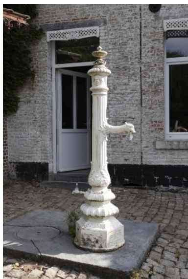
Vue de la pompe à eau située dans la cour. Phot. Pierre Thibaut IVR31_20095903309NUCA
