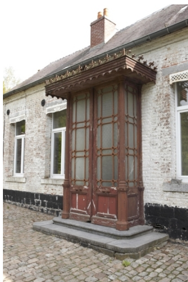
Détail du porche vitré hors-oeuvre en menuiserie. Phot. Pierre Thibaut IVR31_20095903329NUCA
