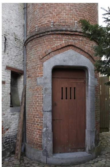
Détail de la porte de la tourelle d'escalier.
