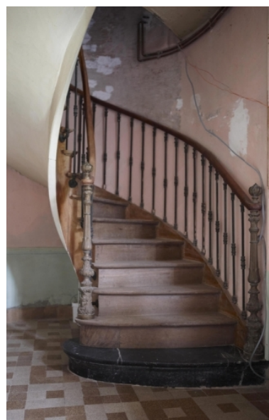
Vue de l'escalier situé dans le bâtiment abritant les pièces de réception. Phot. Pierre Thibaut IVR31_20095903304NUCA
