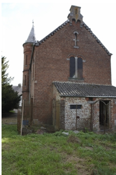
Vue du pignon des écuries. Phot. Pierre Thibaut IVR31_20095903317NUCA
