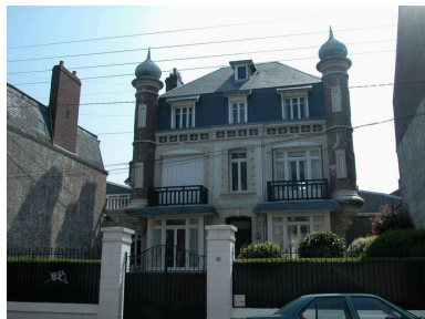
Vue d'ensemble depuis la rue. Phot. Elisabeth Justome IVR22_20058002522NUCA
