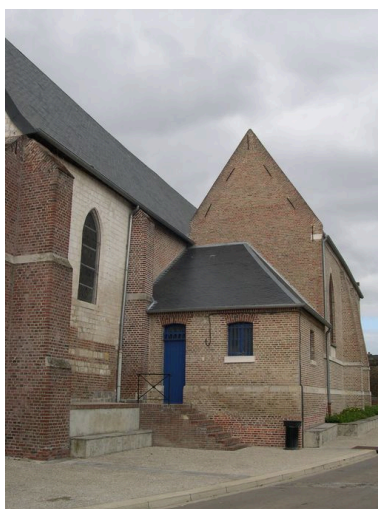
Vue de la sacristie et du mur nord du chœur, depuis l'est. Phot. Isabelle Barbedor IVR22_20068010018NUCA
