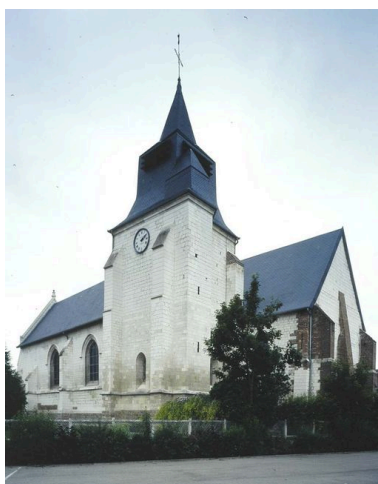
Vue générale. Phot. Thierry Lefébure IVR22_20068000354VA
