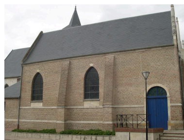
Vue du bas-côté nord. Phot. Isabelle Barbedor IVR22_20068010019NUCA
