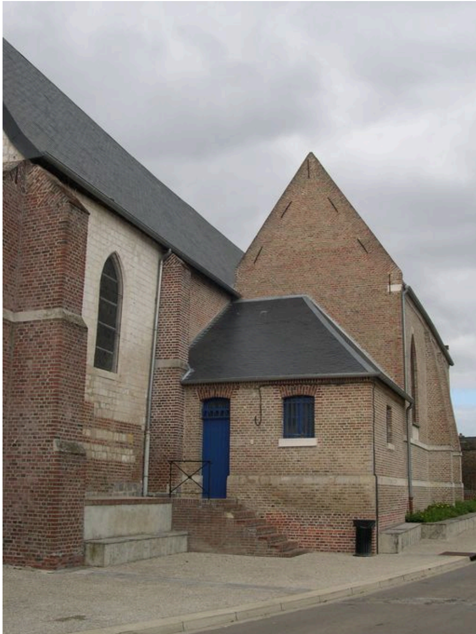
Vue de la sacristie et du mur nord du choeur, depuis l'est.
