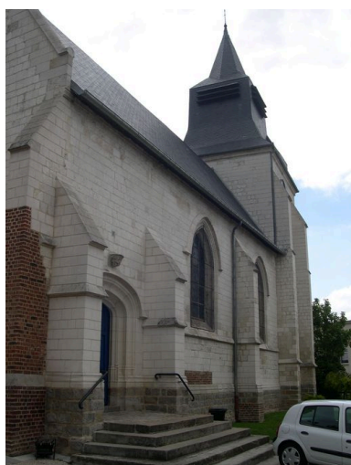
Vue de la façade sud. Phot. Isabelle Barbedor IVR22_20068010014NUCA
