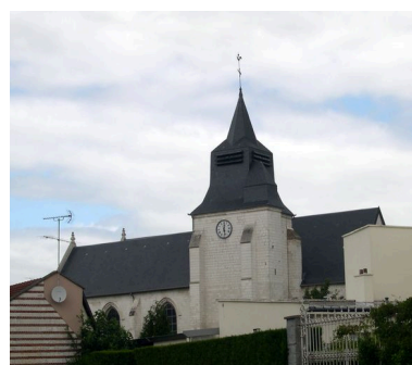
Vue de situation depuis le sud. Phot. Isabelle Barbedor IVR22_20068010011NUCA
