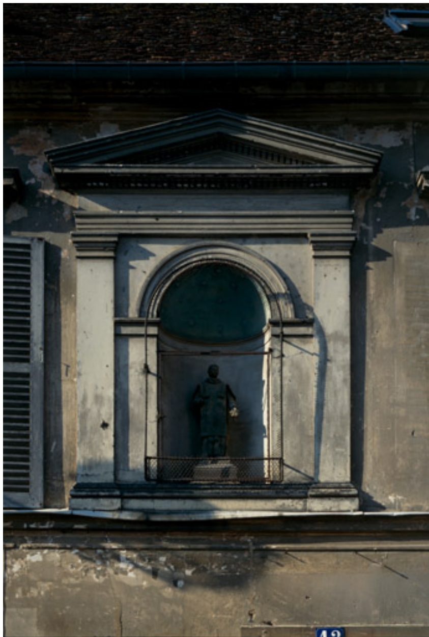
Niche de la façade abritant une statue de saint Vincent.
