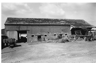
Grange-étable. Phot. Laurent Jumel IVR22_19980202882X
