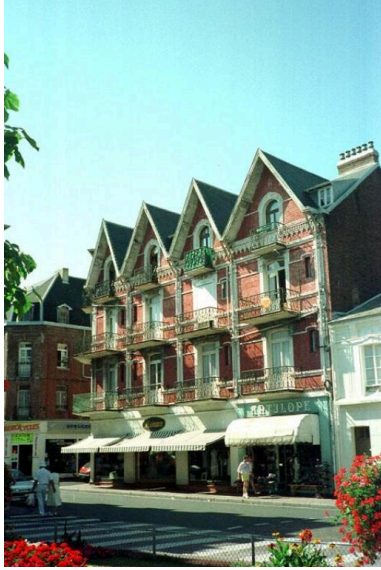
Vue générale. Phot. Richard Klein IVR31_19966201540ZE
