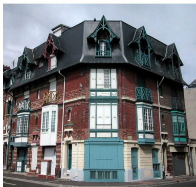
Vue d'ensemble depuis la rue Paul-Viguiier. Phot. Elisabeth Justome IVR22_20038005232NUCA
