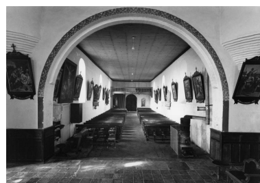
Vue intérieure, depuis le chœur. Phot. Thierry Lefébure IVR22_19930202020V
