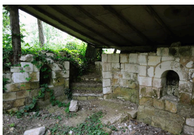
Atelier d'artisan (n° 1) en bordure de l'ancien bief de dérivation des moulins. Phot. Marie-Laure Monnehay-Vulliet IVR22_20128001092NUC2A
