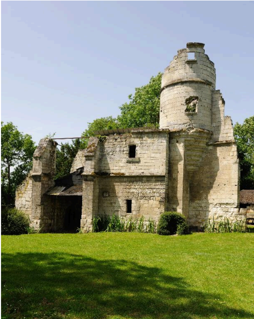
Porterie, vue extérieure depuis l'est.
