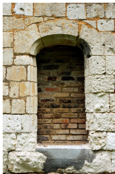
Baie murée d'un bâtiment prioral. Phot. Marie-Laure Monnehay-Vulliet IVR22_20128001083NUC2A
