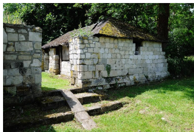
Ancien bâtiment bordant le cloître au sud. Phot. Marie-Laure Monnehay-Vulliet IVR22_20128001123NUC2A
