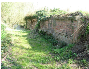
Mur de clôture moderne bordant l'ancien fief de dérivation. Phot. Frédéric Fournis IVR22_20128015586NUCA
