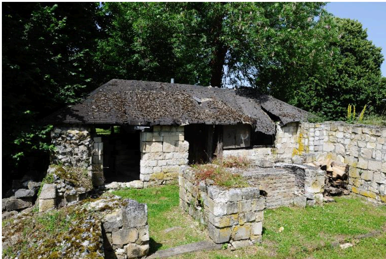
Ancien bâtiment au sud du cloître.
