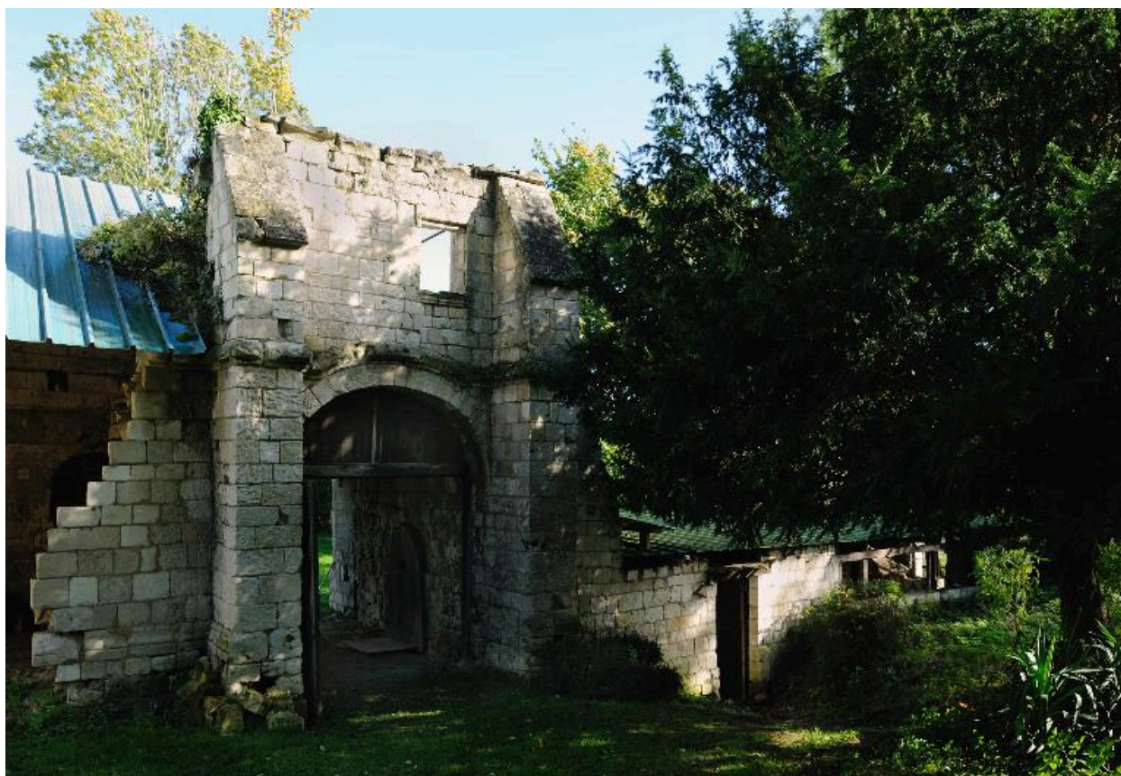
Porterie et ancienne infirmerie, vue intérieure.
