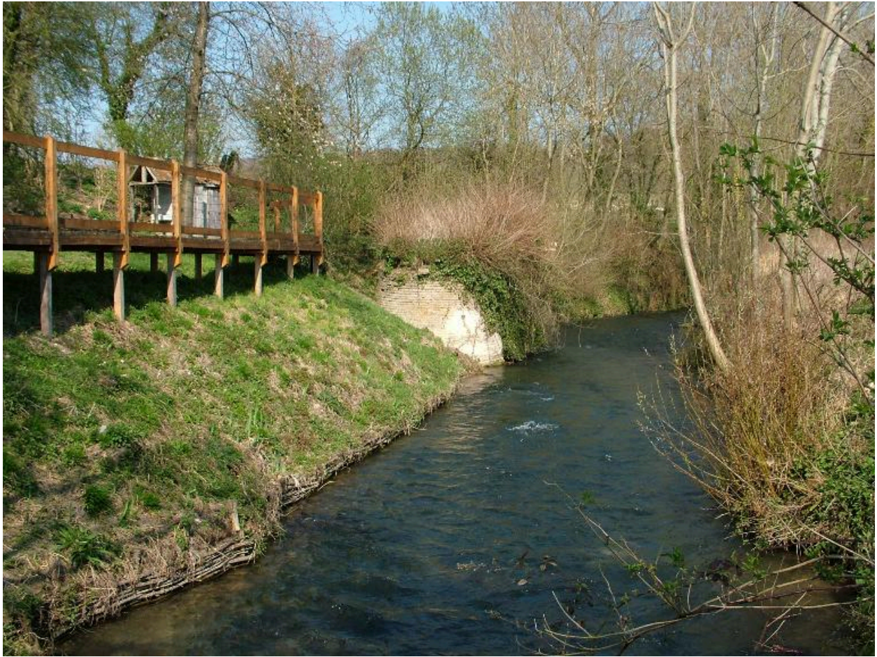
La Nièvre avec le massif de maçonnerie commandant la confluence avec l'ancien bief de dérivation.
