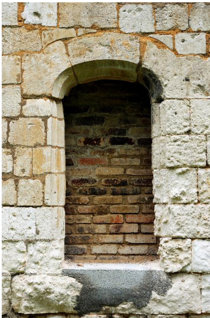
Baie murée d'un bâtiment prioral.
