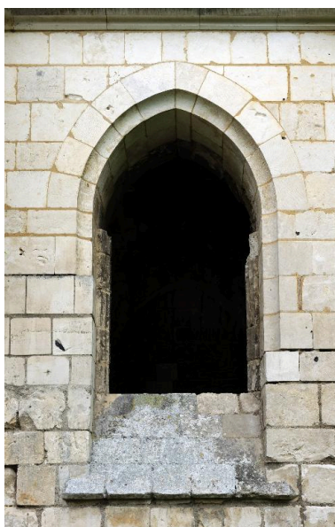
Baie d'un bâtiment prioral. Phot. Marie-Laure Monnehay-Vulliet IVR22_20128001075NUC2A
