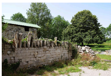
Ancienne salle du trésor à l'est du cloître. Phot. Marie-Laure Monnehay-Vulliet IVR22_20128001111NUC2A
