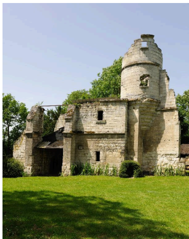
Porterie, vue extérieure depuis l'est. Phot. Marie-Laure Monnehay-Vulliet IVR22_20128001119NUC2A
