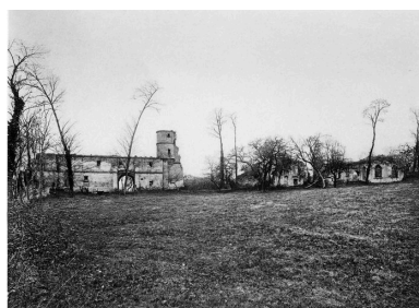
Vue générale des vestiges du prieuré par P. Dujardin (In : La Picardie historique et monumentale). Phot. Monnehay-Vulliet Marie-Laure IVR22_20108000047NUCA
