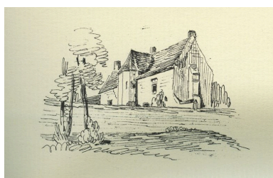
Vue de l'ancien logis prieural par Louis Duthoit, milieu du 19e siècle (In : Aimé et Louis Duthoit..., 1979). Phot. Monnehay-Vulliet Marie-Laure IVR22_20108000032NUCA
