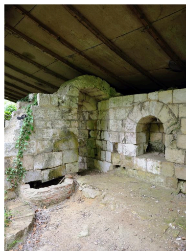
Atelier d'artisan (n° 2) en bordure de l'ancien bief de dérivation des moulins. Phot. Marie-Laure Monnehay-Vulliet IVR22_20128001090NUC2A
