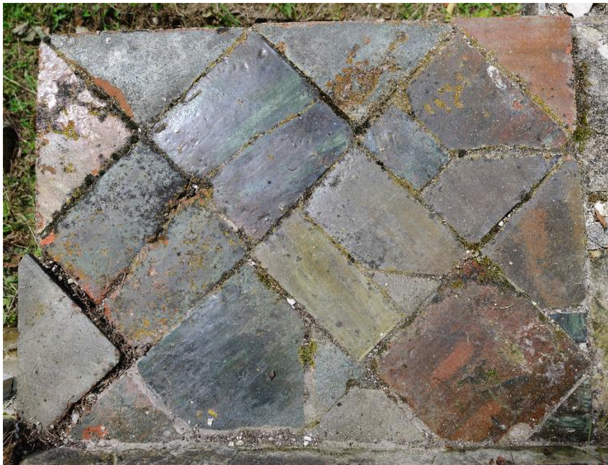
Éléments de carrelage de grès dans la nef de l'ancienne église priorale.
