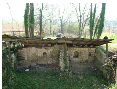
Anciens ateliers d'artisans bordant au sud l'ancien bief de dérivation. Phot. Frédéric Fournis IVR22_20128015585NUCA
