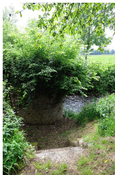
Maçonnerie à la jonction de l'ancien du bief de dérivation des moulins avec la Nièvre. Phot. Marie-Laure Monnehay-Vulliet IVR22_20128001088NUC2A
