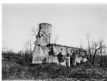
Vue des vestiges de l'ancienne infirmerie par P. Dujardin (In : La Picardie historique et monumentale). Phot. Monnehay-Vulliet Marie-Laure IVR22_20108000048NUCA
