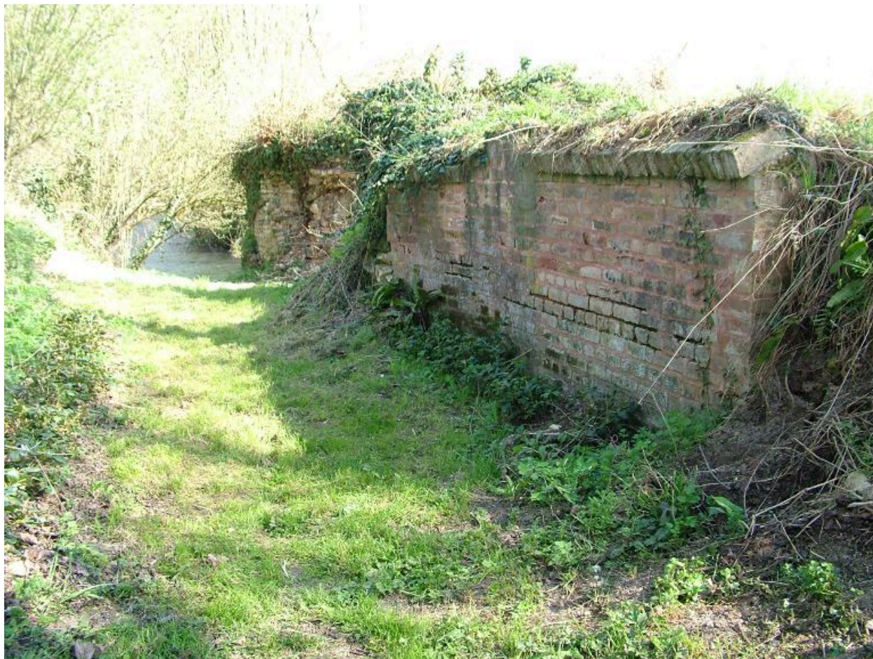
Mur de clôture moderne bordant l'ancien fief de dérivation.
