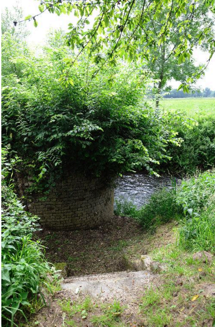
Maçonnerie à la jonction de l'ancien du bief de dérivation des moulins avec la Nièvre.
