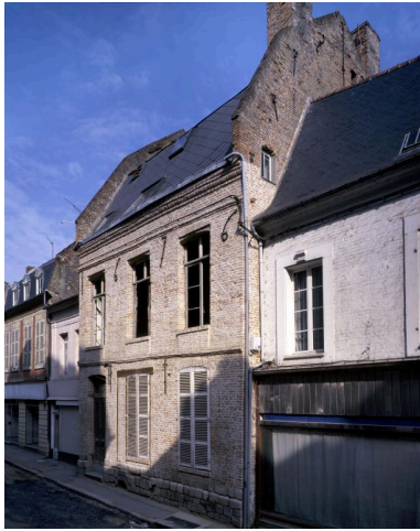
Vue de la façade sur rue. Phot. Thierry Lefébure IVR22_19990202680VA
