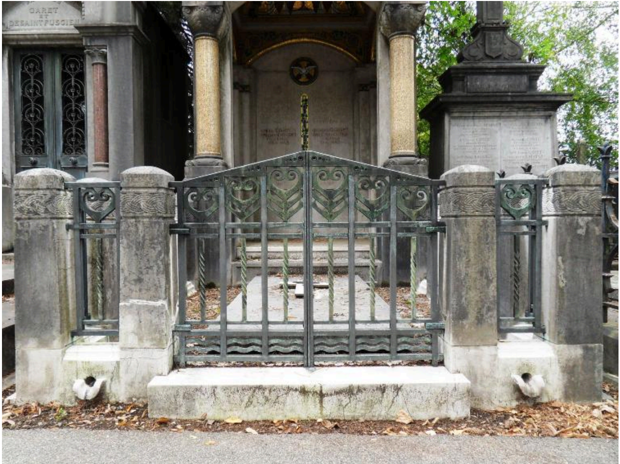
Vue de détail de la clôture.
