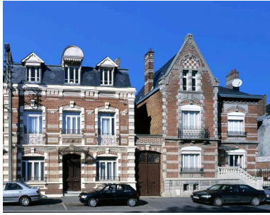
Vue de situation, maison à droite de l'image.
