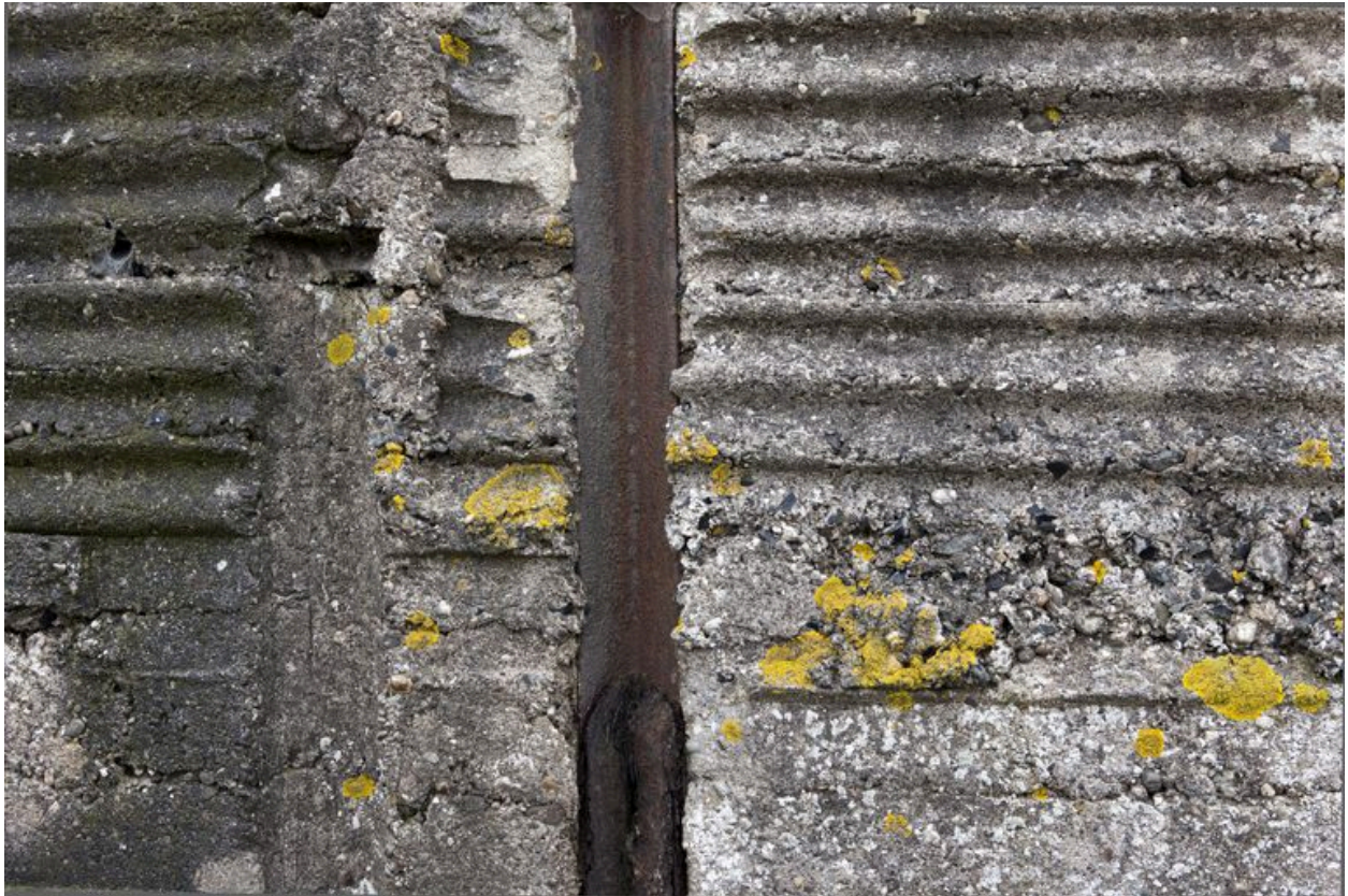
Elévation nord, détail de traces de coffrage
