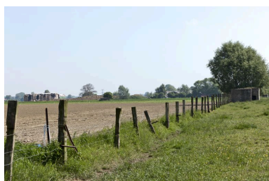
Vue générale vers le nord-est Phot. Jean-Marc Ramette IVR31_20145905490NUCA
